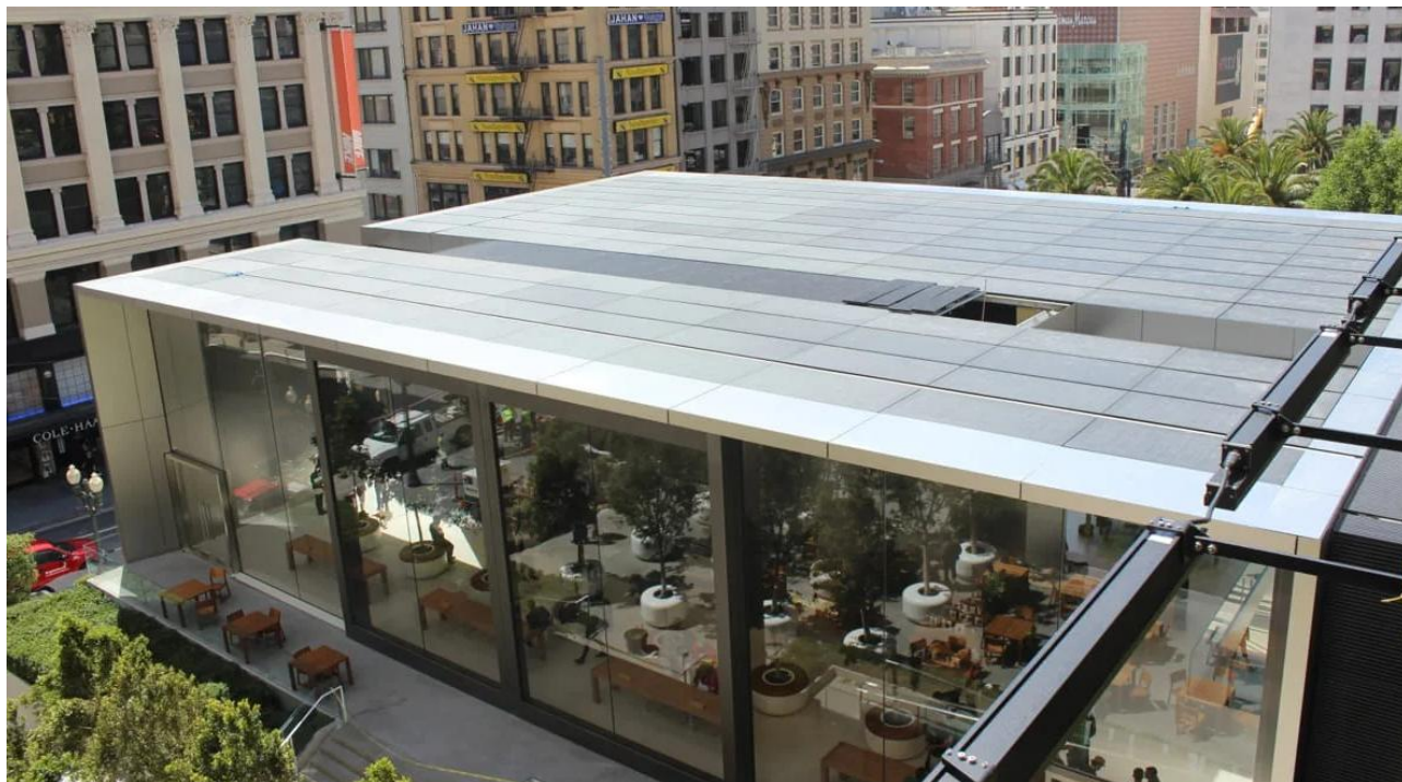
圖6 舊金山 APPLE STORE 頂上安裝可行走光電地板 (資料來源：翻攝自 ONYX SOLAR 提供書面資料)
