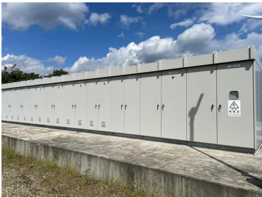
圖 13、西鄉太陽光電案場內 30kV 升壓站
