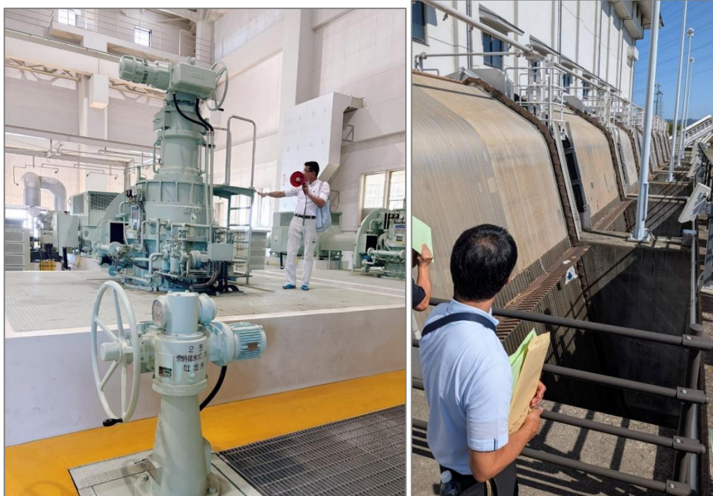
圖4-3-4 巨椋池排水機場-原動機與減速機(左圖)、除污機(右圖)
