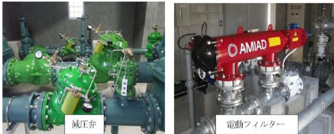
圖1. 減壓閥及電動過濾器
