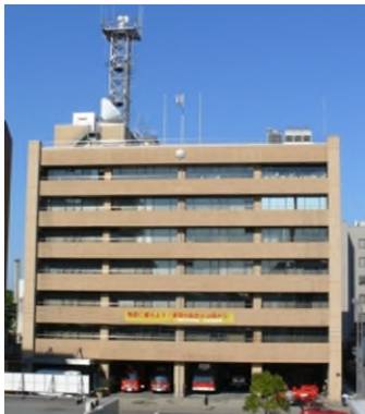
圖 39 仙台市消防局辦公大樓
