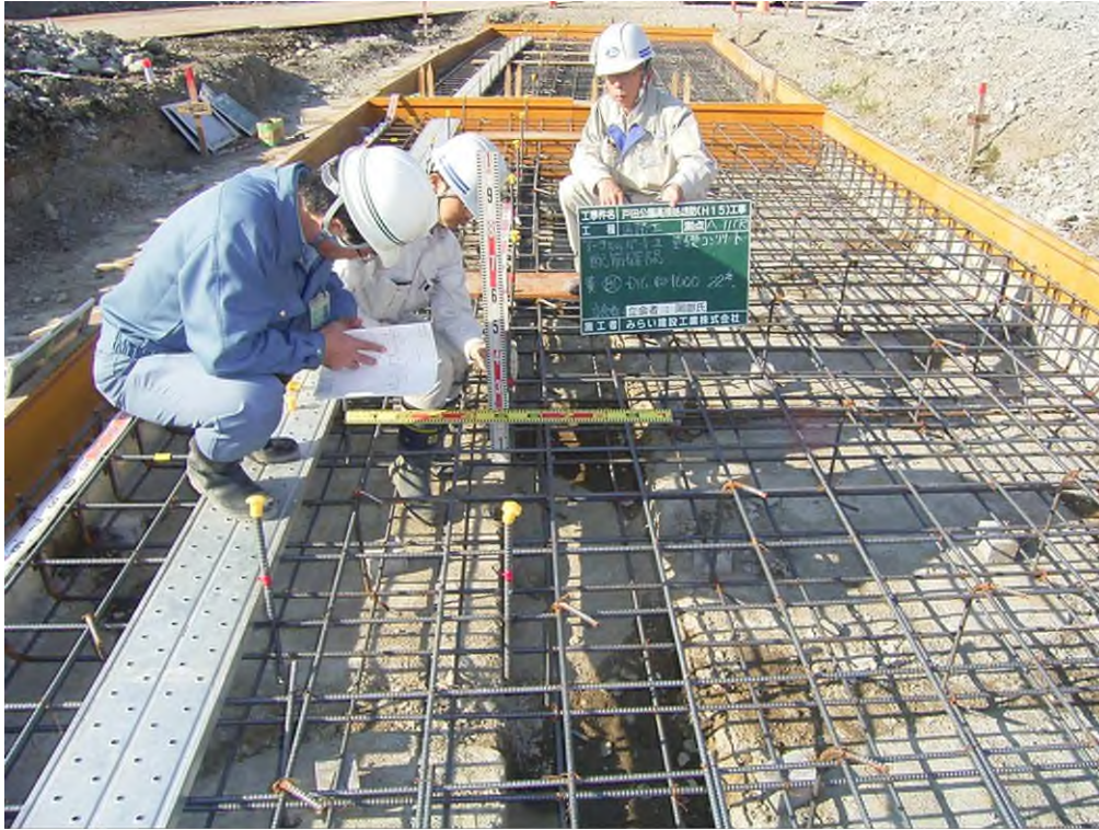
現場監督-確認場鑄混凝土之鋼筋尺寸及組立(國土省資料)
