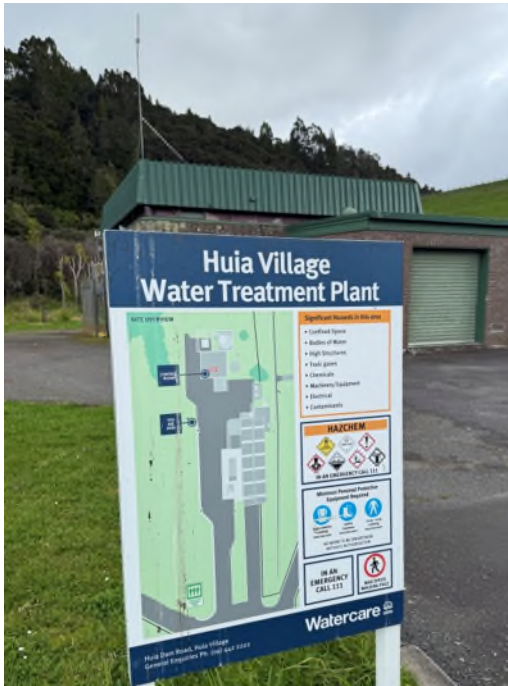
圖 5、供應 Huia Village 用水小型水處理設備 (後方綠色屋頂)
