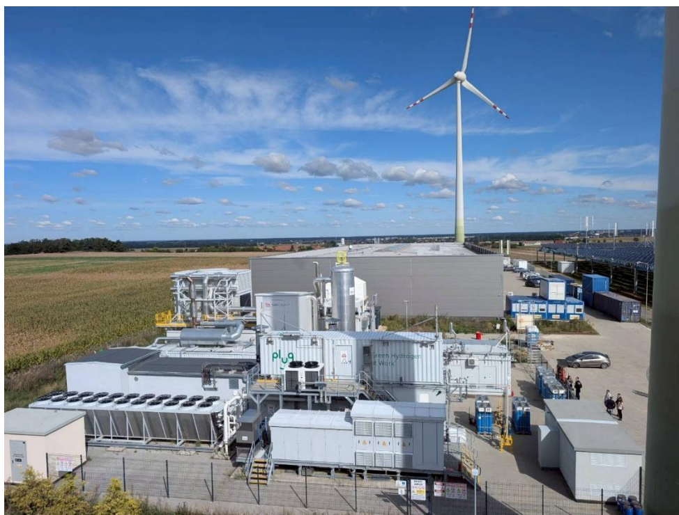
圖 5、Promet-Plast 公司利用多元綠能進行發電，最大風機達 3MW，並結合綠電 產氫與燃料電池系統，並以氫氣供應供應電、熱、冷三種能源
