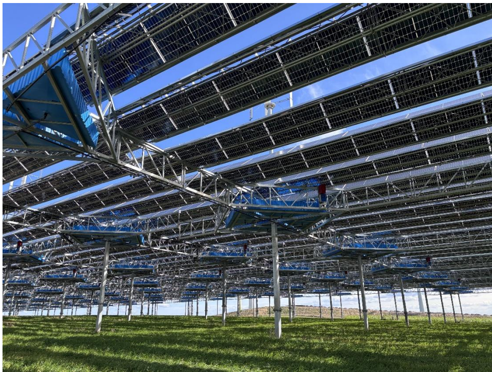
圖 8、Promet-Plast 推動農業型光電系統（Agro-PV），在農地上結合太陽能板與 水資源管理系統，不僅能蓄水、灌溉作物，亦能同時發電。上圖藍色裝置即為蓄 水容器。
