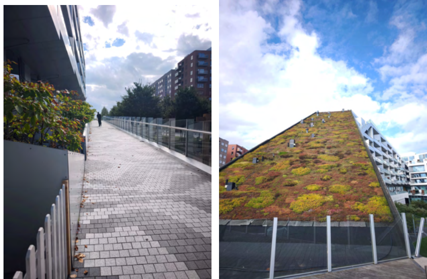
圖 12 8 Tallet 內斜坡道與屋頂綠化 (攝於 2025/9/11)
