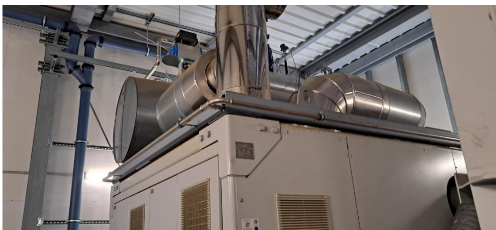
圖 47、燃料電池系統高溫尾氣冷卻裝置
