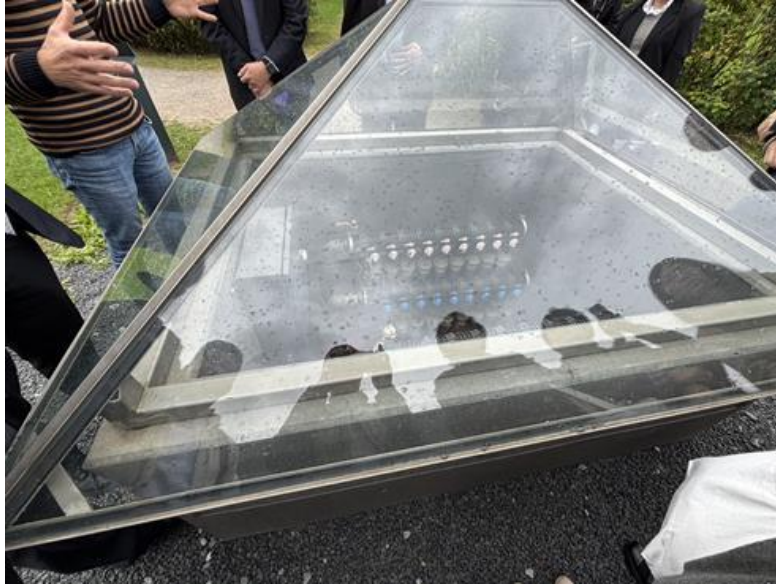
圖 3、地熱分配豎井內部構造
