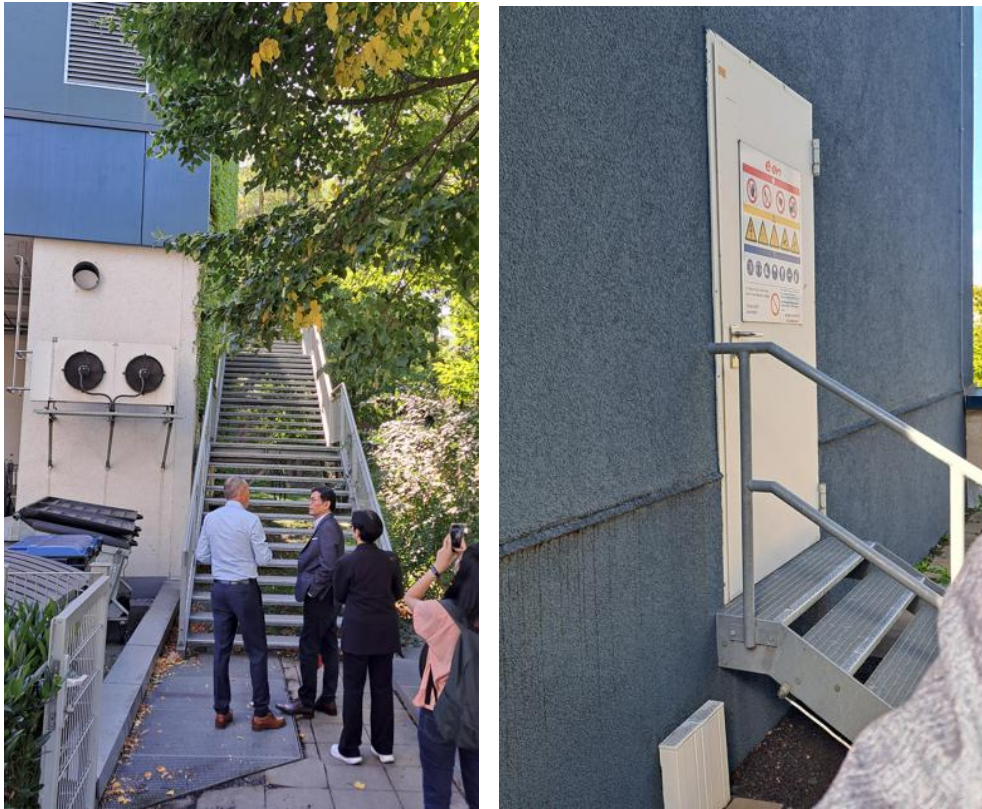
圖 44、麗笙飯店燃料電池設置場域外觀
