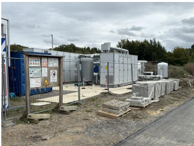
圖 8、協助不同溫度加熱之地表熱泵
