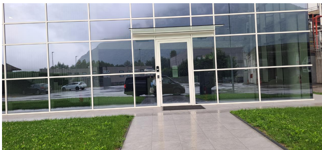
圖 49、SolydEra量產工廠外觀
