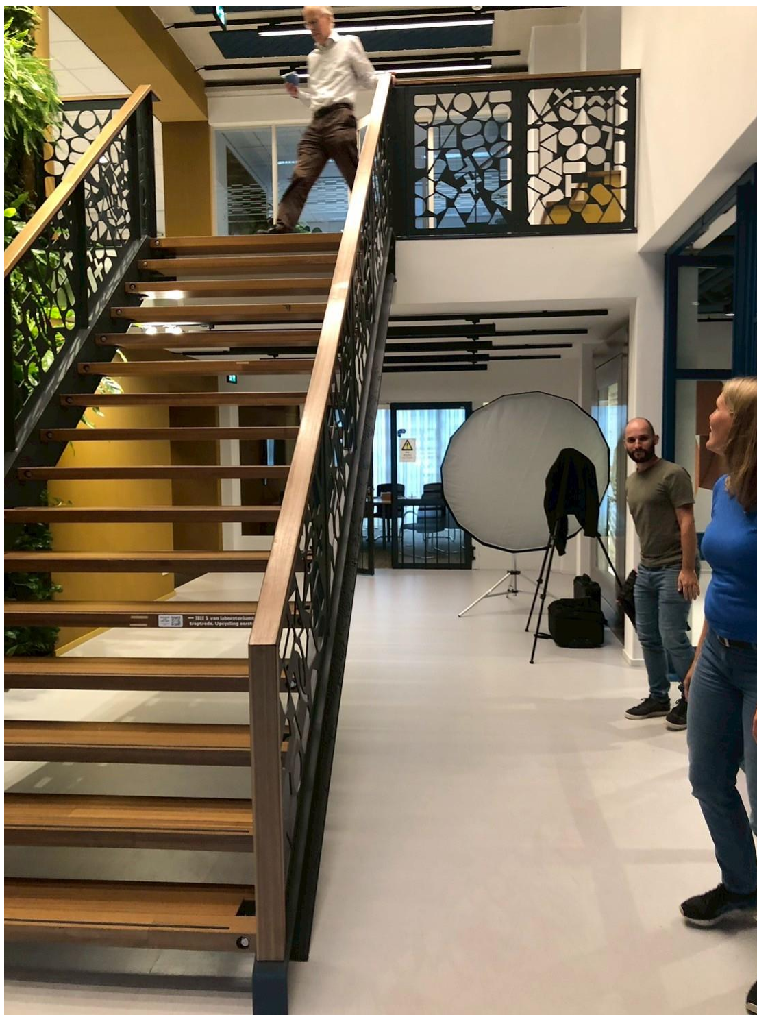
圖片說明：樓梯使用屋頂鋼樑，樓梯踏步係大學實驗室廢棄桌板，樓梯扶手廢棄鋼板設計造型沖孔，循環再利用而成。
