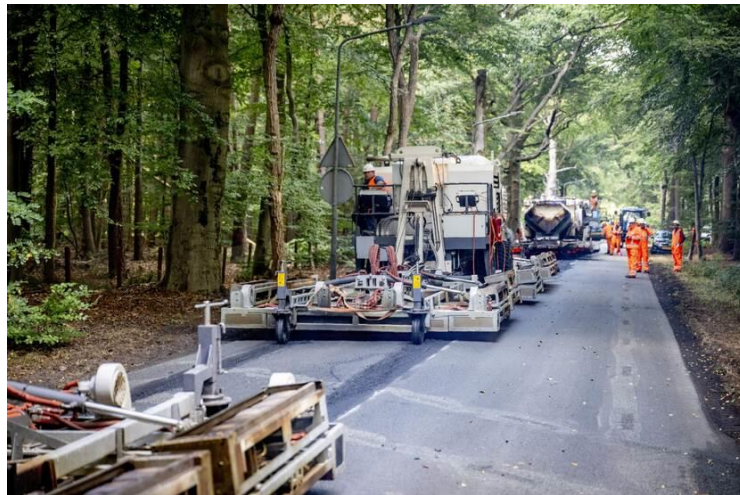
圖片說明：瀝青再生列車（Asphalt Recycling Train，ART），荷蘭 Dura Vermeer Infra 公司創新部門仍在研發測試中，圖片來源 ©Photo： ANP / Hollandse Hoogte / Robin Utrecht / Infraside.nl。
