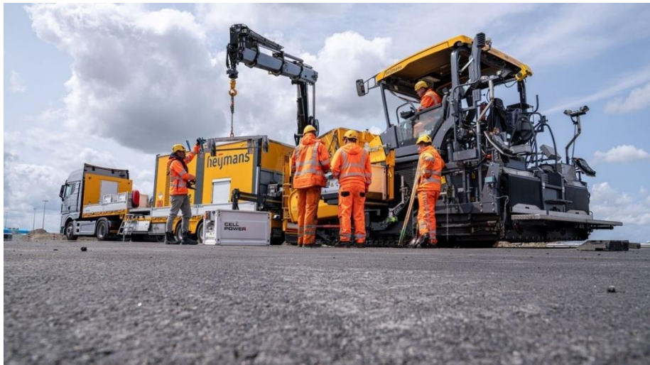
圖片說明：透過建置「全電力施工機具（非傳統柴油引擎燃）行
