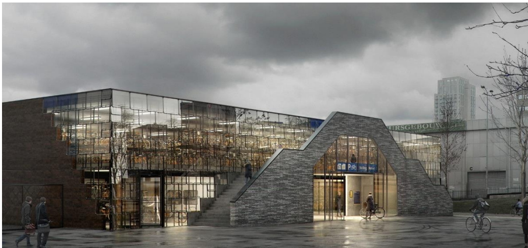
圖片說明：建築師事務所 Architekten Cie. 規劃將 600 扇火車車窗，再利用於建築物外牆立面。圖片來源： https://www.cie.nl/circulaire-fietsenstalling?lang=nl
