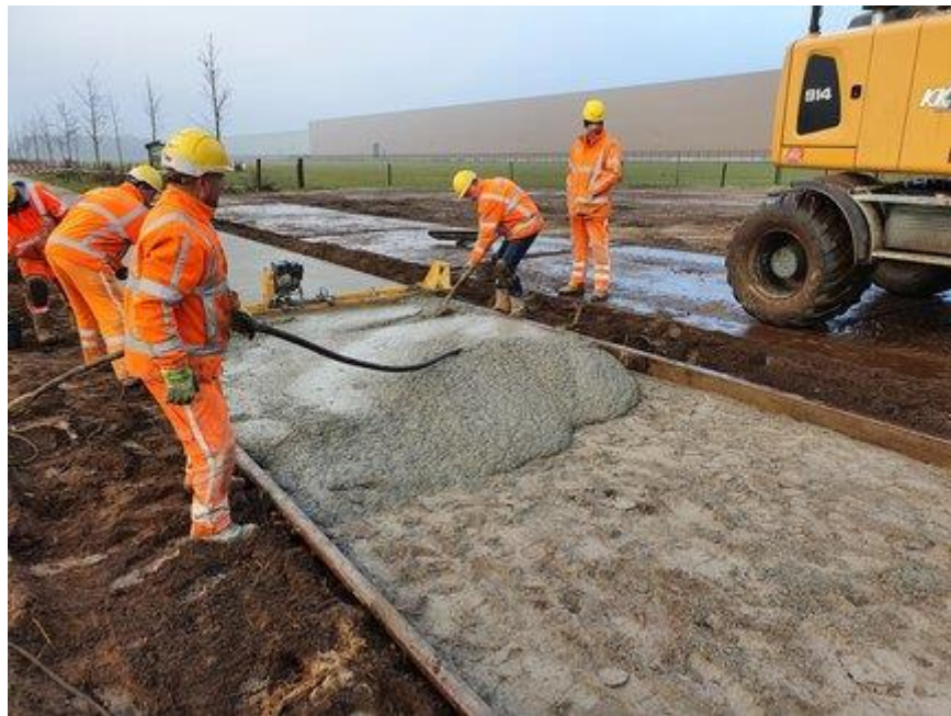
圖片說明：Heijmans 與 Zwolle 市政府試點計畫，自行車鋪面使用之混凝土，係由 100%再生礫石、50%再生砂及 15%再生水泥所組成。圖片來源：Heijmans。
