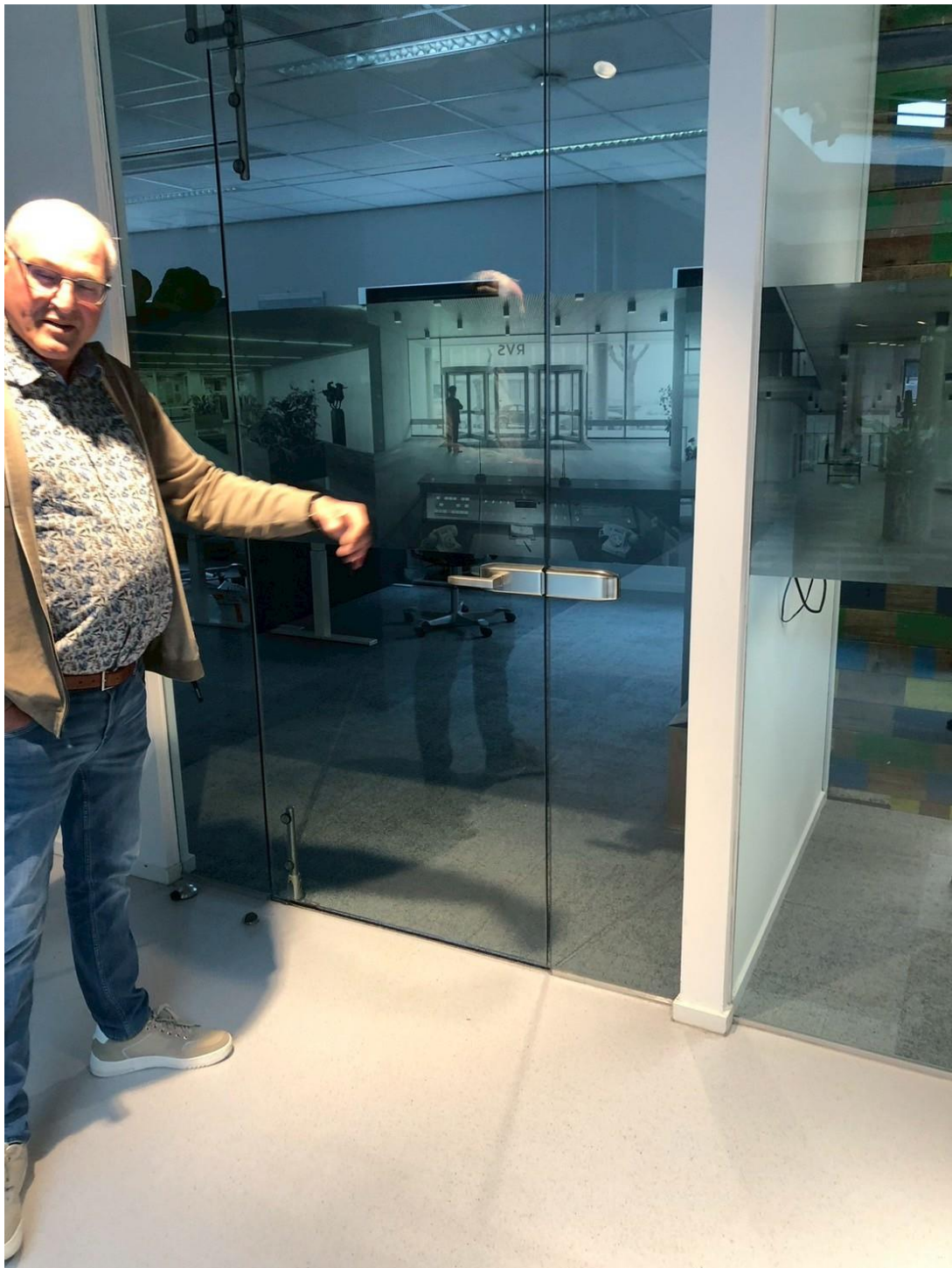
圖片說明：某辦公室之入口大大門（含五金繫件），係利用某辦公室拆除廢棄之二手門扇，循環再利用而成，整個辦公室內有形形色色，不同門扇、五金繫件，來自不同來源地、生產者或供應者。
