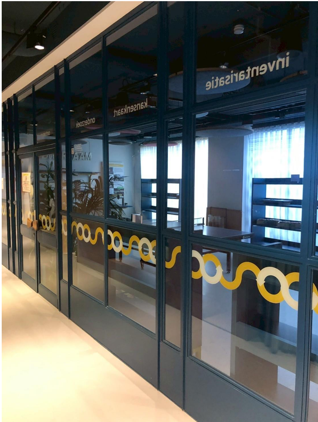
圖片說明：辦公室之室內隔間含玻璃，部分係利用某醫院拆除廢棄之二手隔間，循環再利用而成，整個辦公室內有形形色色，不同門扇、五金零件、隔間，來自不同來源地、生產者或供應者。
