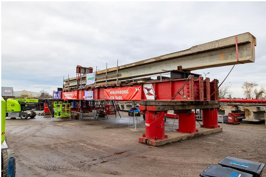
圖片說明：A9 高速公路使用之舊混凝土梁，由 RWS 另案透過 SBIR 循環高架橋計畫，測試其再利用可行性。圖片來源： https://betonenstaalbouw.nl/ 。
