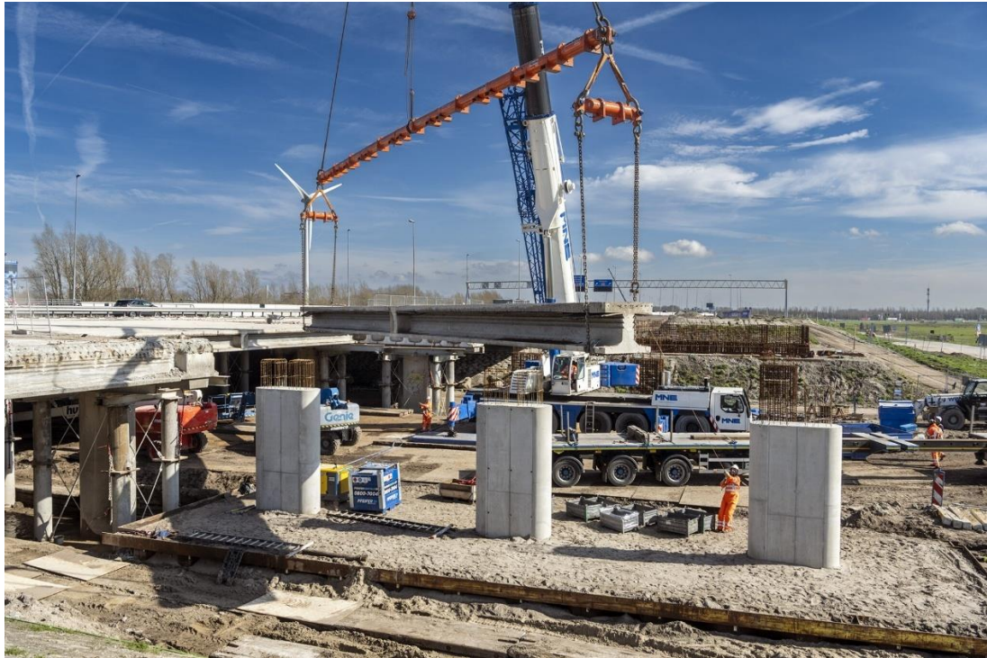
圖片說明：本案 FCC 營造廠與 RWS 約定，既有 A9 高速公路使用之舊混凝土梁，因配合拓勘寬拆卸後，將吊裝於 RWS 其他工程案中再利用。圖片來源： RWS 。
