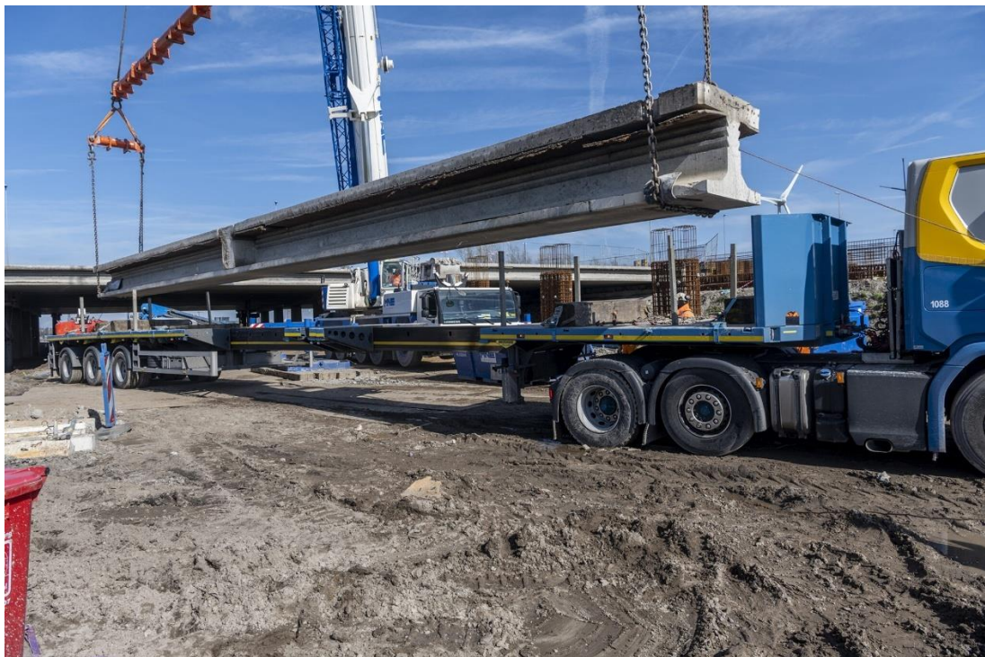
圖片說明：既有 A9 高速公路使用之舊混凝土梁，配合拓勘寬拆卸後，進行吊裝，供採購機關於其他工程案中再利用。圖片來源： RWS 。
