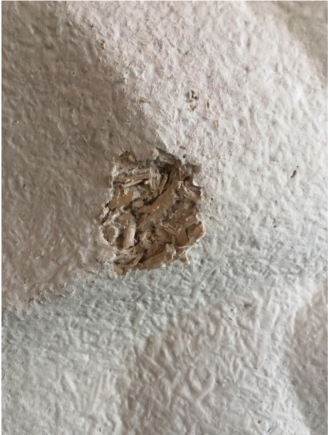
圖片說明： Biosintrum 中心會議室，使用白色吸音隔牆，採用生物菌絲體（Mycelium）填充料，屬於促進自然資源保育與環境保護為目的，節省能源、節約資源、減少溫室氣體排放之技術規格。
