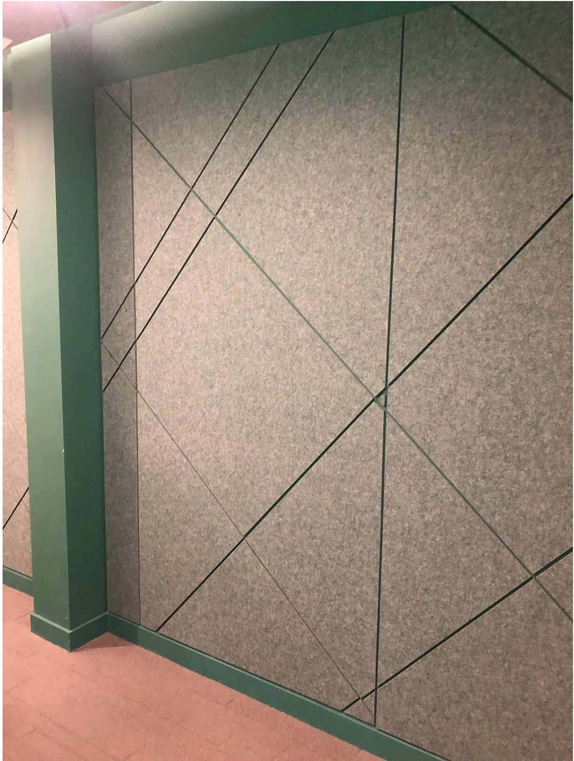
圖片說明：三樓討論區之會議室隔音板，係利用寶特瓶塑膠纖維壓制，循環再利用而成，隔音效果很好。
