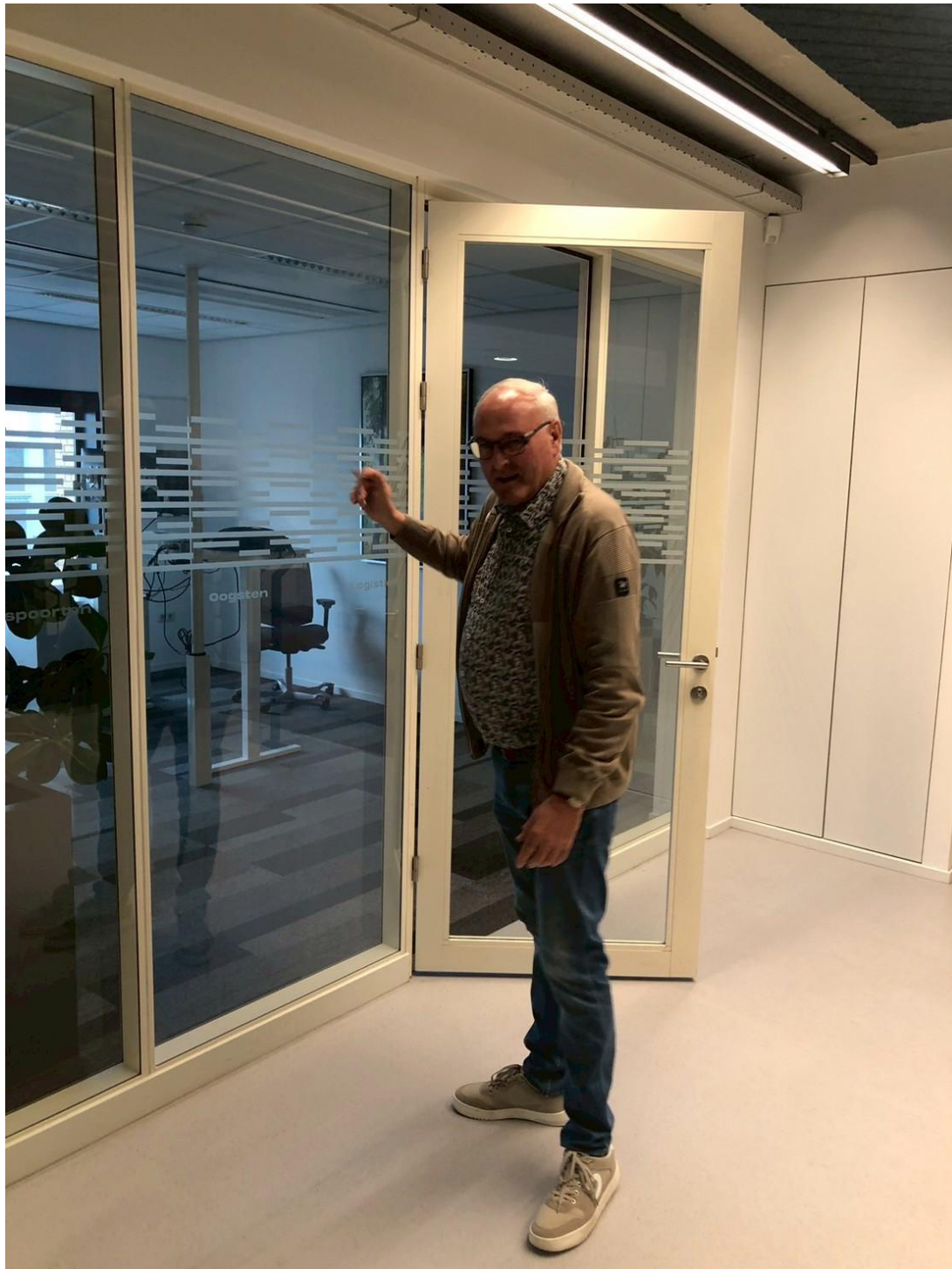
圖片說明：辦公室之室內隔間含玻璃，部分係利用其他辦公室廢棄之二手隔間，循環再利用而成，整個辦公區內有形形色色，不同門扇、五金零件、隔間，來自不同來源地、生產者或供應者。
