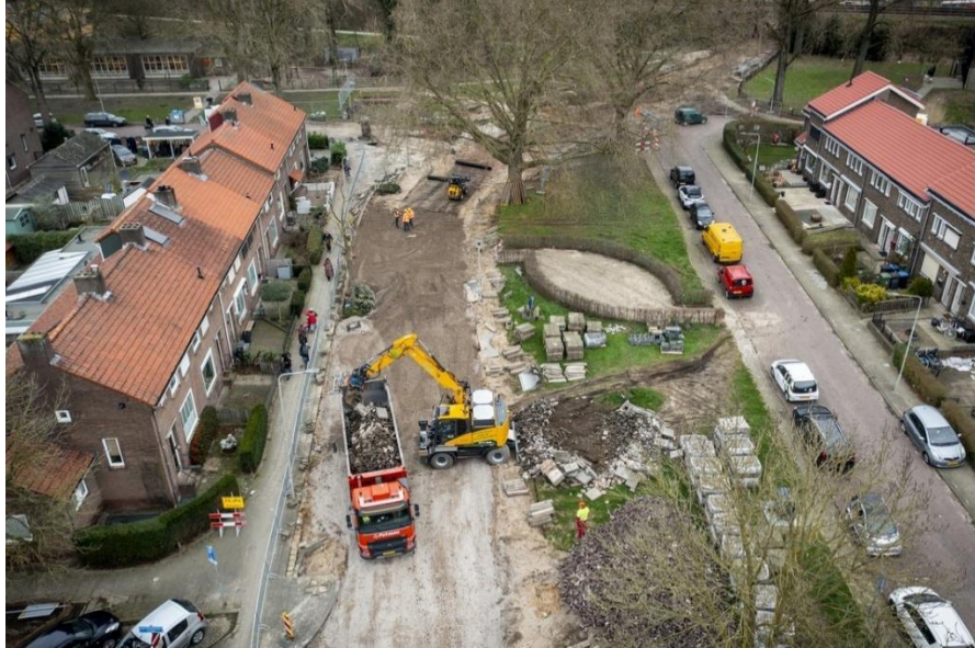
圖片說明：Heijmans 與 Arnhem 市政府，在 Hugo de Grootstraat 自行車專用道工程中，合作試驗，盡可能僅使用電力（非傳統柴油引擎燃油）施工機具。圖片來源：Heijmans。
