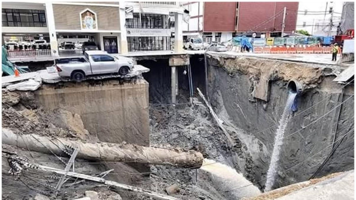
圖 19 泰國曼谷地下自來水管線爆裂產生約30平方公尺、深50公尺的巨大坑洞
