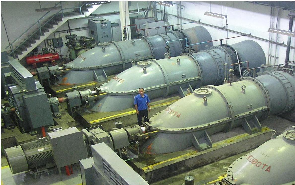
圖9 薩姆萊原水抽水站-橫軸式泵浦
