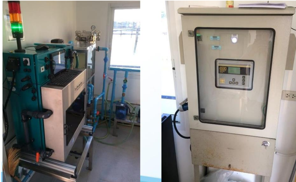
圖10 薩姆萊原水抽水站-水質監測設備
