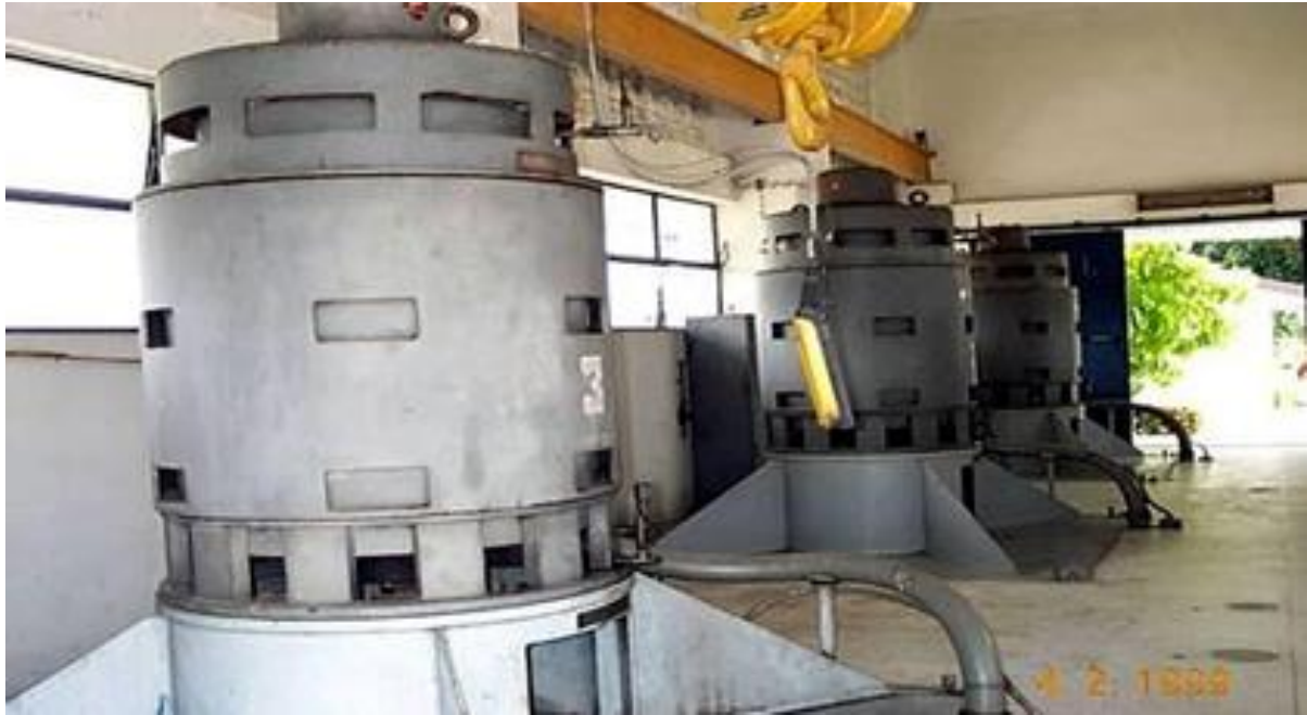
圖8 薩姆萊原水抽水站-豎軸式泵浦
