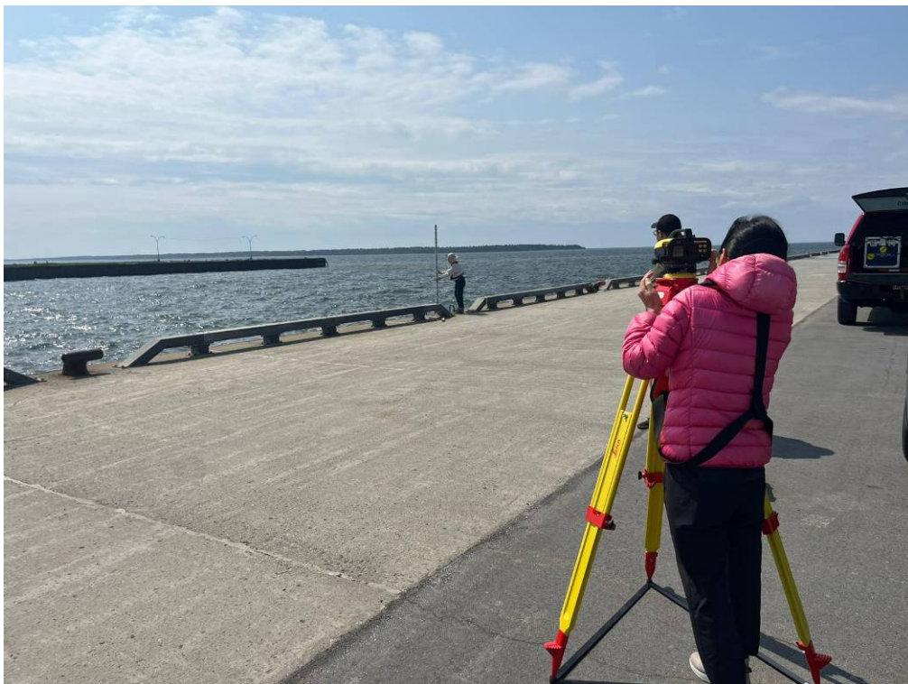
圖 10、以水準儀測量自設潮位站高程
