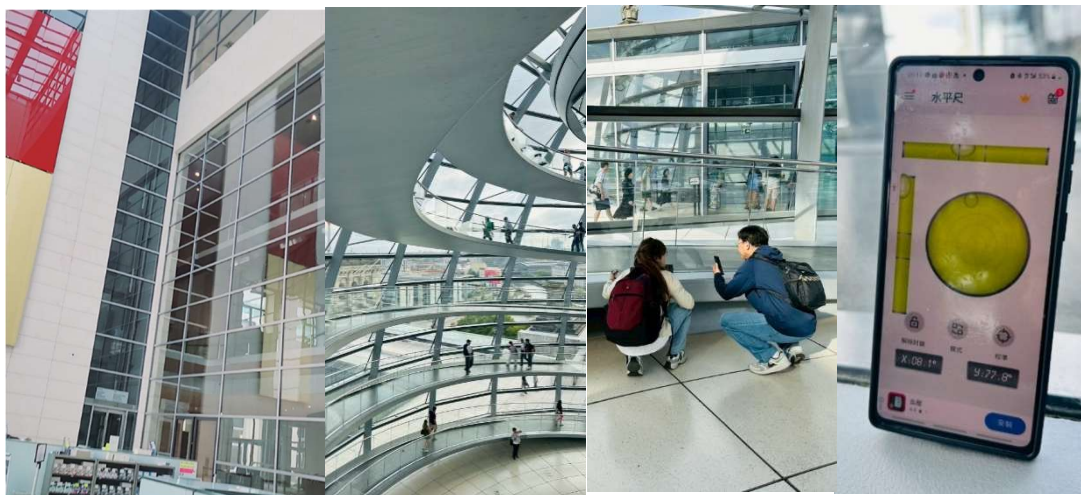
圖 2.14 德國柏林國會大廈內部與圓頂內部視角及檢測走道坡度
