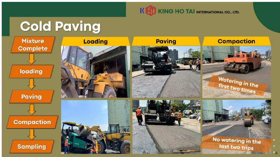
圖 7、冷拌瀝青流程
