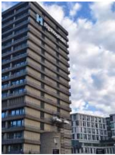
圖 11 Rigshospitalet 醫院大樓外觀
