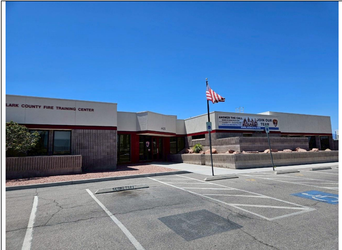
圖 - 上課地點 CLARK COUNTY FIRE TRAINING CENTER(CCFTC)
