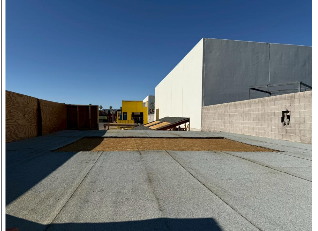
圖-屋頂搶救訓練場景(正面為平面、左側面為斜面)
