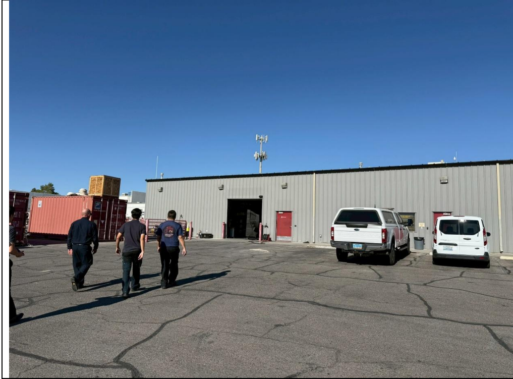
圖-CCGTC 倉儲設施外觀
