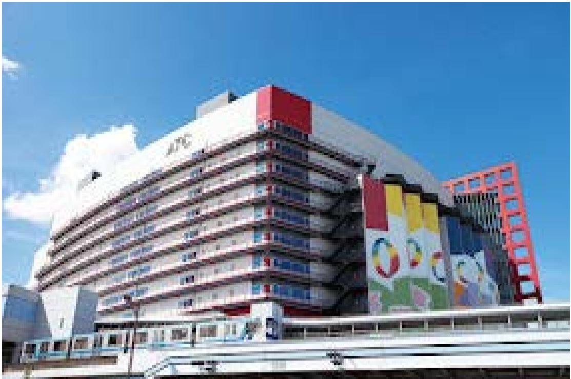
日本大阪亞洲貿易中心(ATC) (照片 1)
