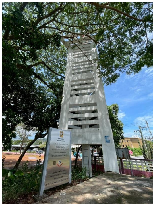
圖 22 海嘯警報塔及其標示牌 1
