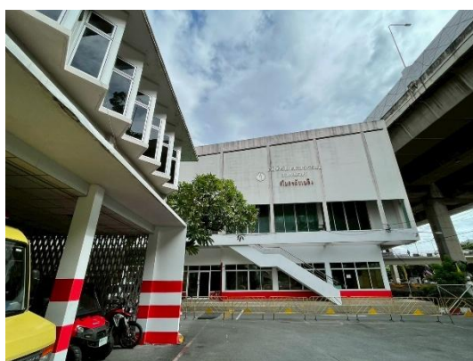
圖 17 BFRD 局本部旁的新建大隊
