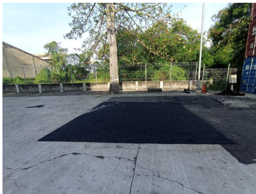
圖 6-8 鋪面修補作業
