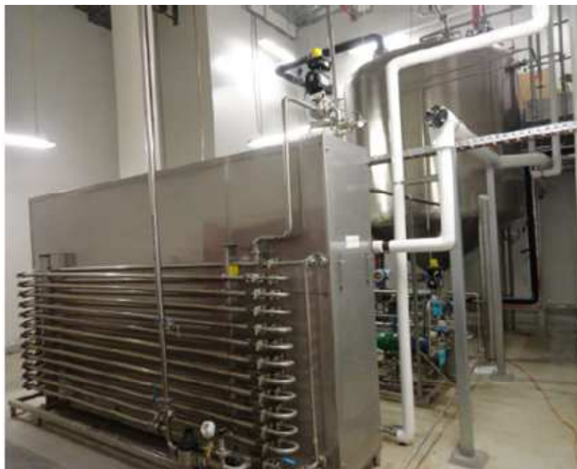
圖 6. Continuous flow 型廢液處理系統。
