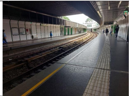
圖 51-地鐵月台設置導盲磚
