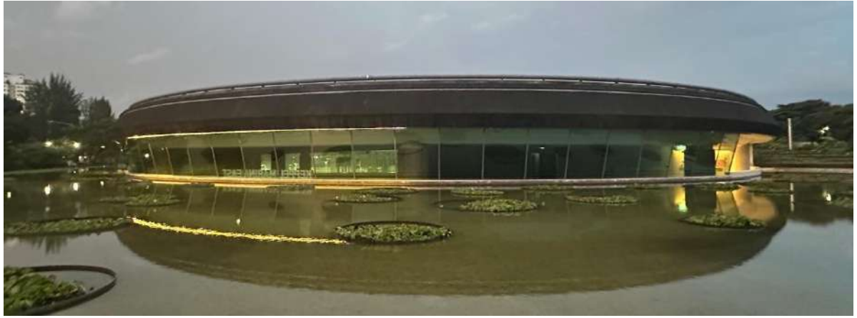
圖八、吉寶濱海東(Keppel Marina East Desalination Plant)海水淡化廠外觀
