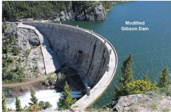
圖 46、Gibson 壩更新改善：壩座加固、壩頂增設女兒牆及破水補氣柱
