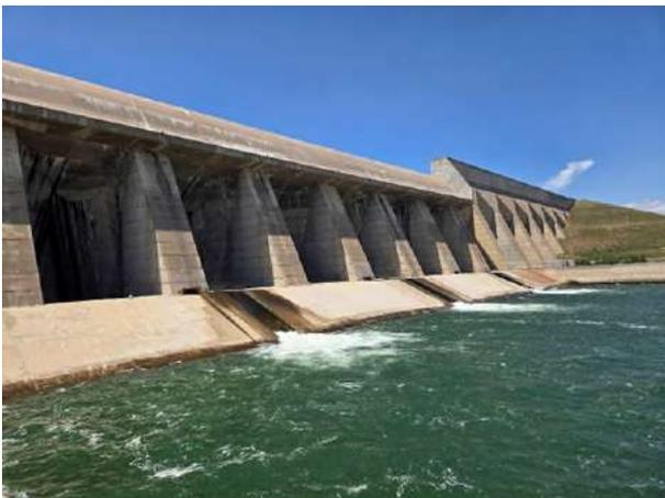
圖 72、河道放水道出水口（放水中）
