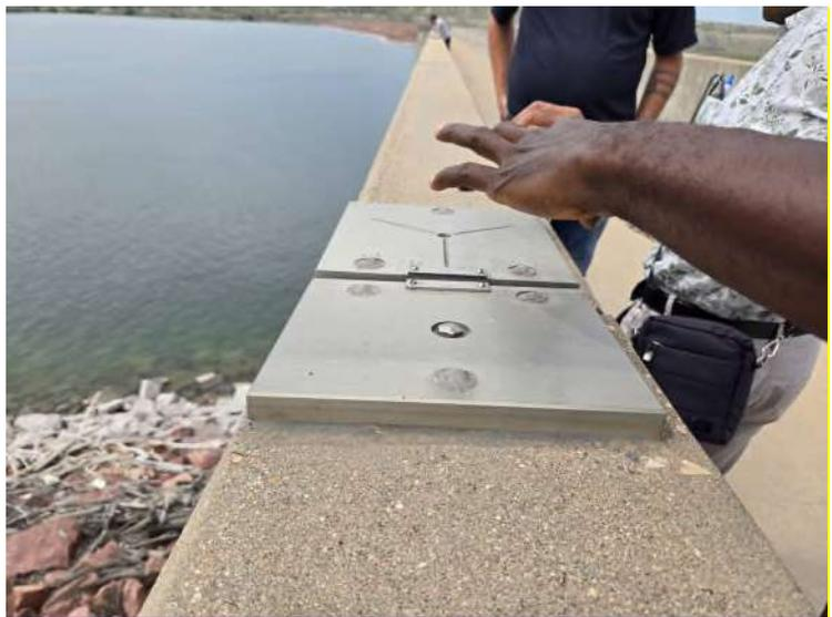
圖 77、混凝土壩接縫處變位監測（需人工量測）
