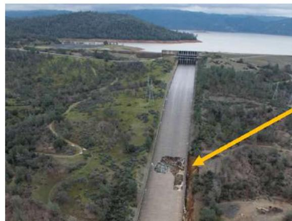
圖 10、奧羅維爾壩主溢洪道槽體破損
