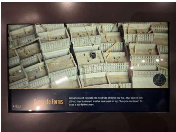
圖 89、壩體混凝土分塊澆築說明
