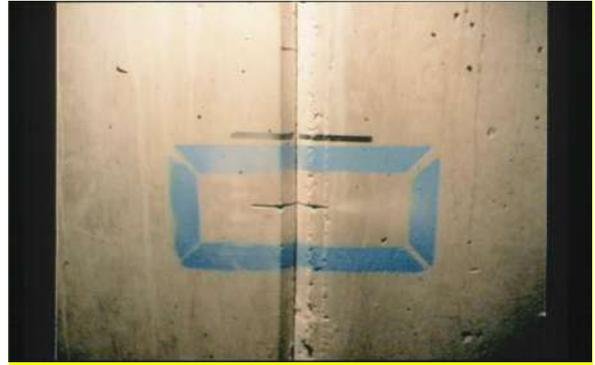
圖 14、接縫處採噴漆或畫線方式監測位移
