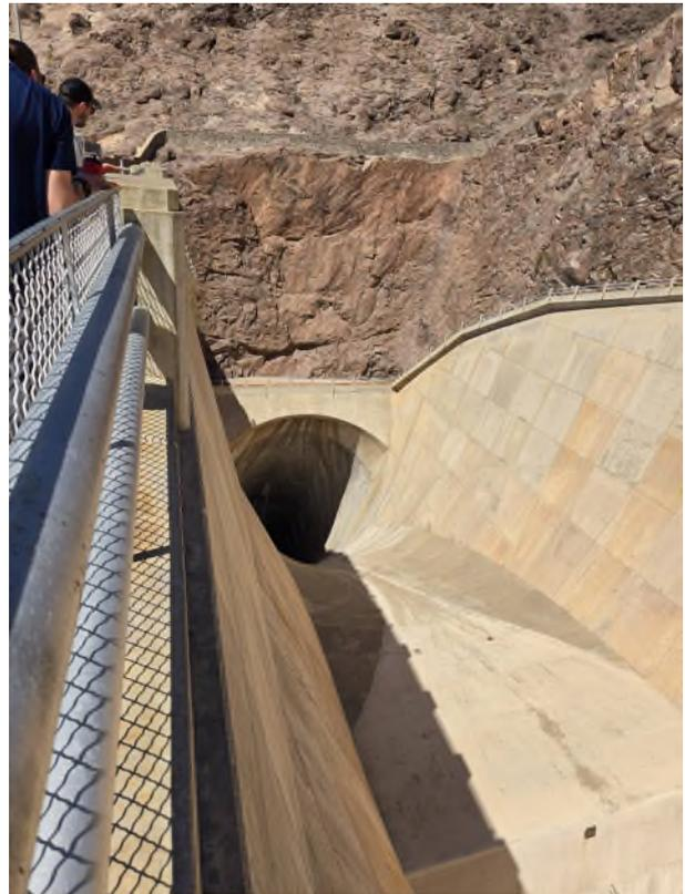
圖 94、溢洪道隧道進水口結構
