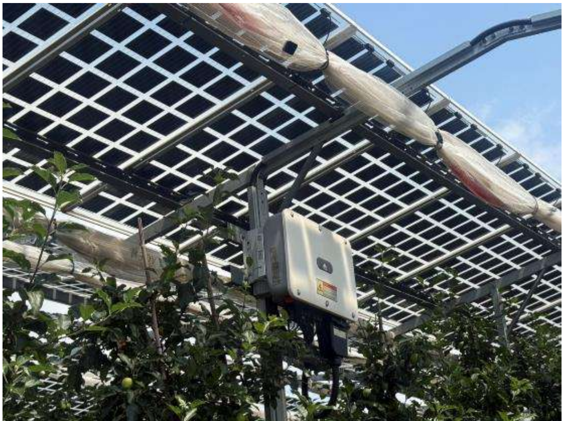
圖 22、光電模組間空隙需遮蔽避免造成果樹真菌性感染
