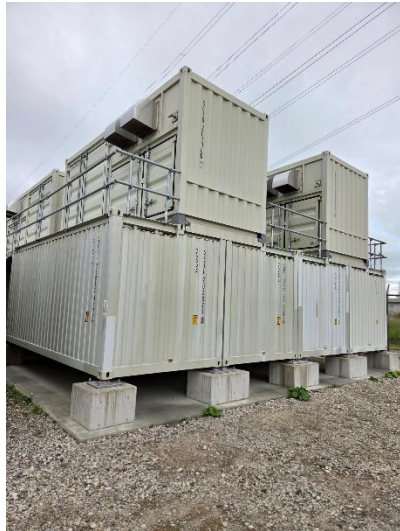
圖 4.5 釩液流電池儲能系統貨櫃型式(左)及 PCS(右)
