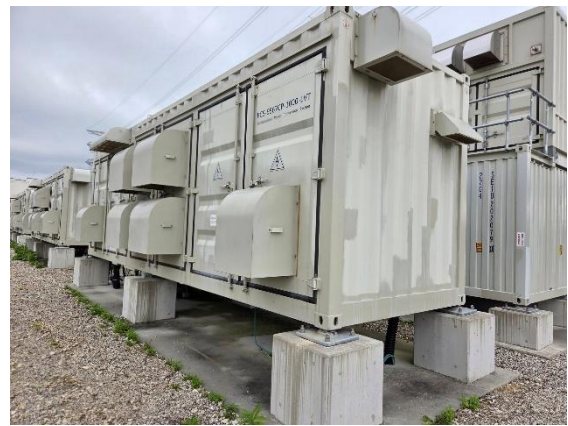
圖 4.5 釩液流電池儲能系統貨櫃型式(左)及 PCS(右)
