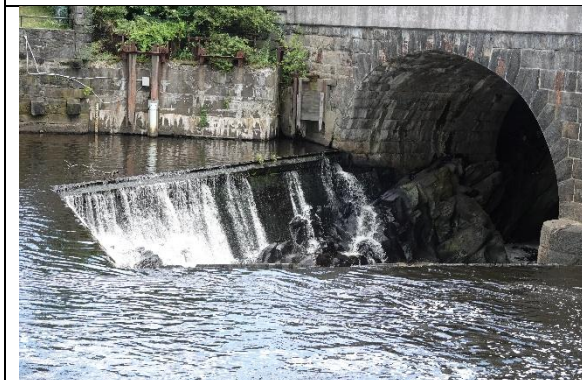
Old Slater Mill 據點附近尚存壩體(左：Main street Dam；右：Slater Mill Dam)，規劃以 vertical slot fishway 方式為魚遷移廊道。
