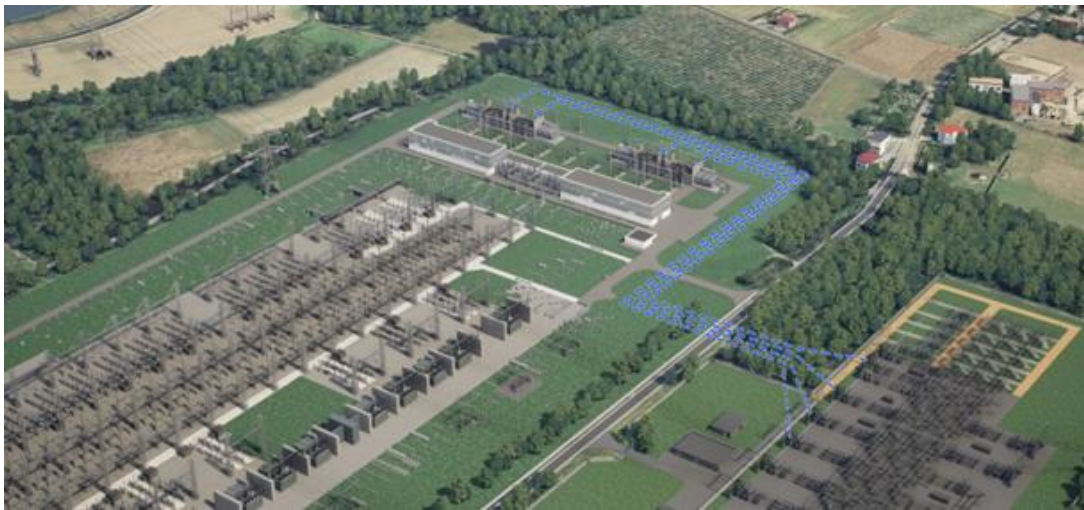
圖 15 變電所內管路路徑
