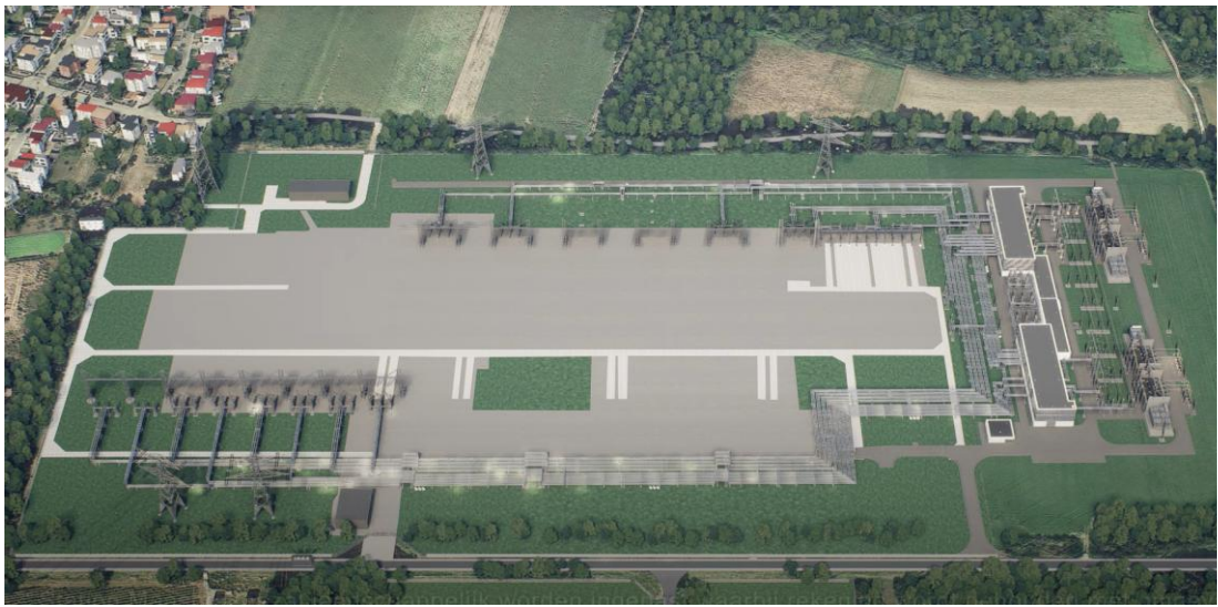
圖 17 改建後拆除舊有設備
