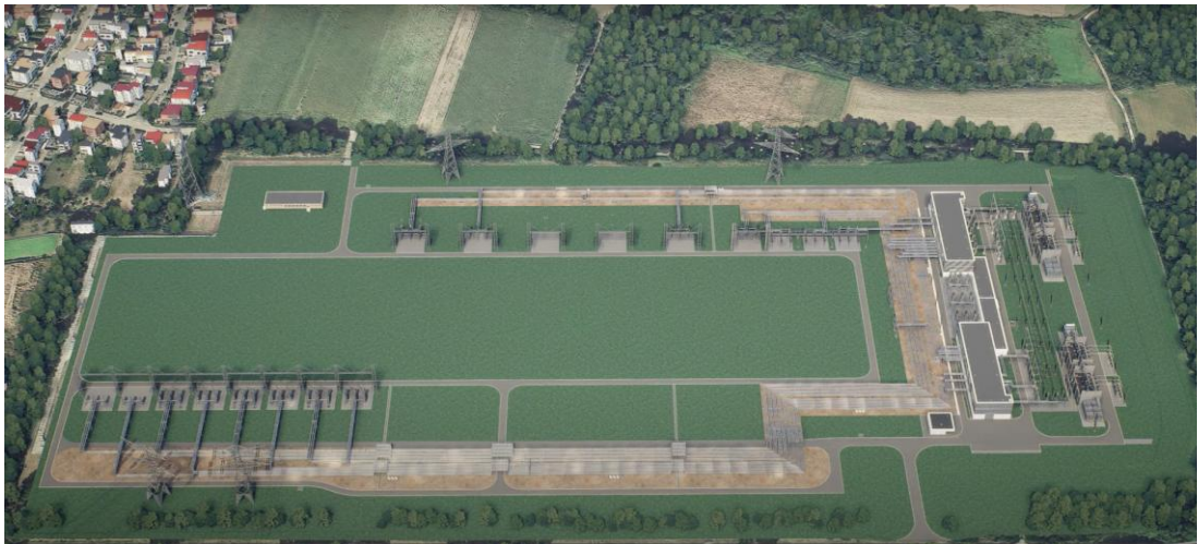
圖 18 原設備空間拆除後恢復綠化
