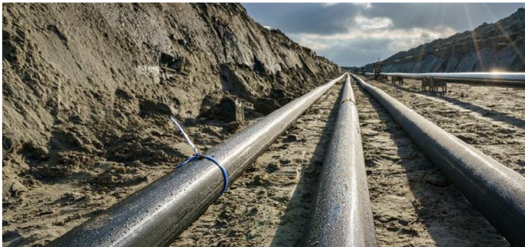
圖 16 150kV 電力電纜直鋪 7
