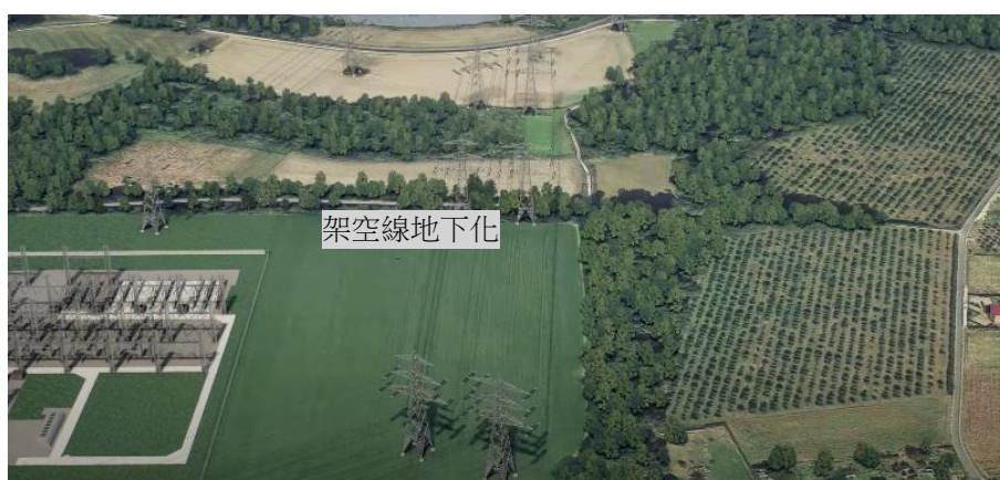
圖 11 改建前聯外線路採架空線 6
