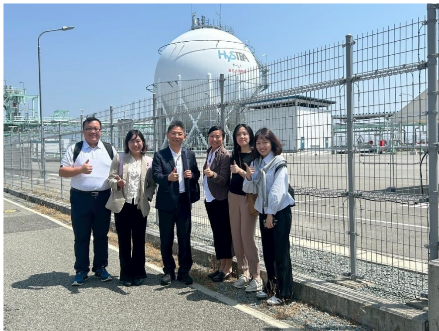
圖 16 神戶港液態氫儲槽
