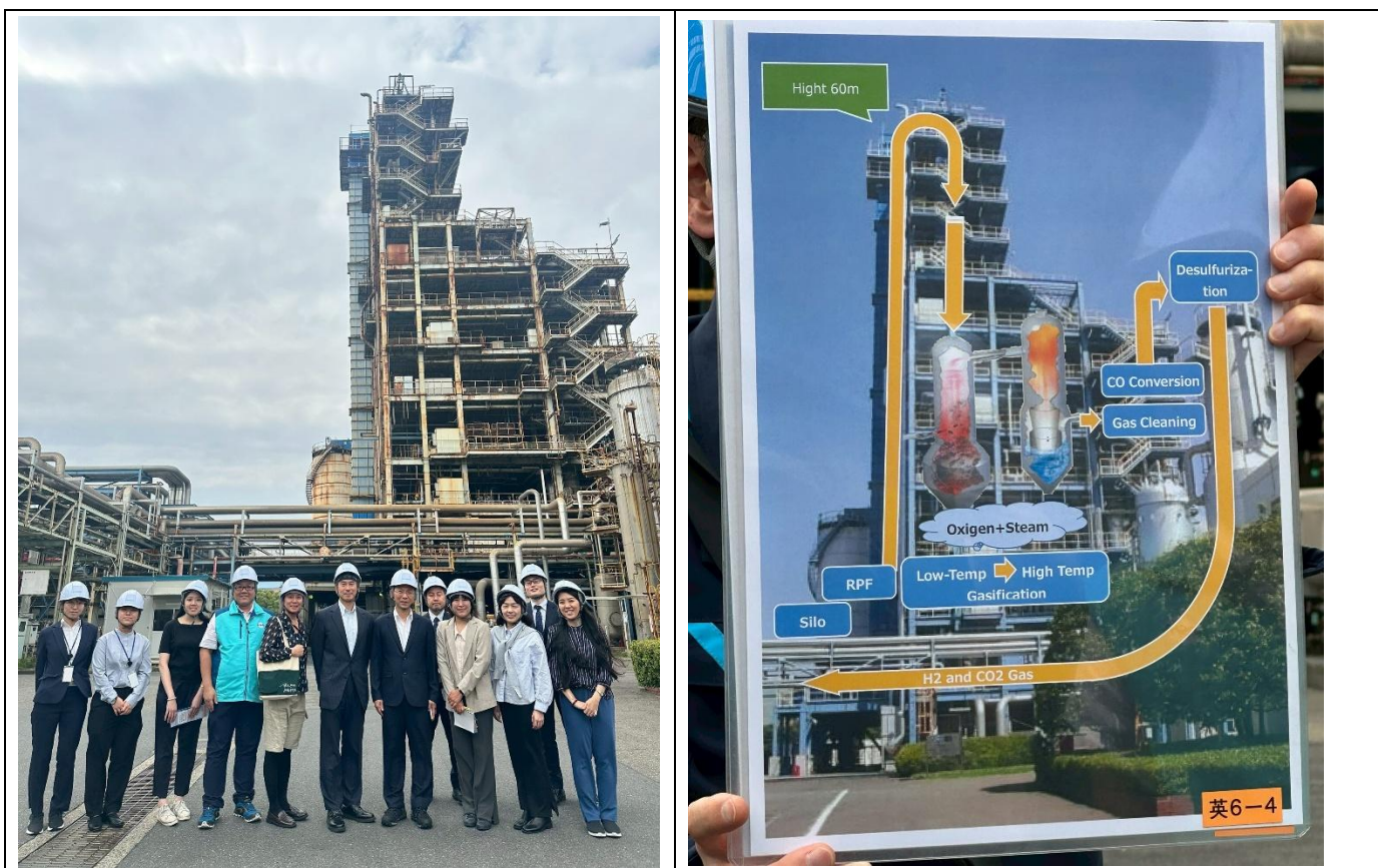
圖 23 燒卻爐相關製氫設備
