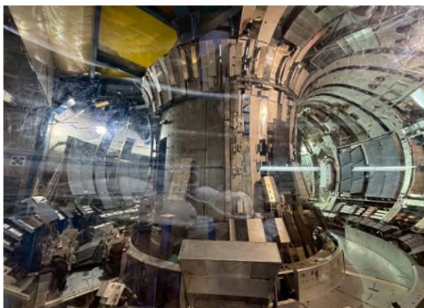
圖 15 JET 內部的環形構造
