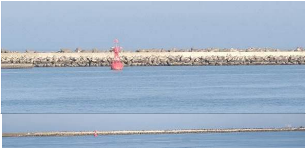
圖 2.10 苫小牧港西港區港內拋石堤及航道標識浮標
