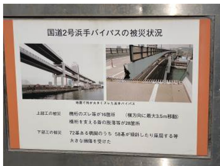
圖2.31 神戸市国道2號線因阪神大地震受損情況
