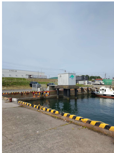
圖2.24 苦小牧港西港區內苦小牧漁港的開孔消波碼頭與岸壁
