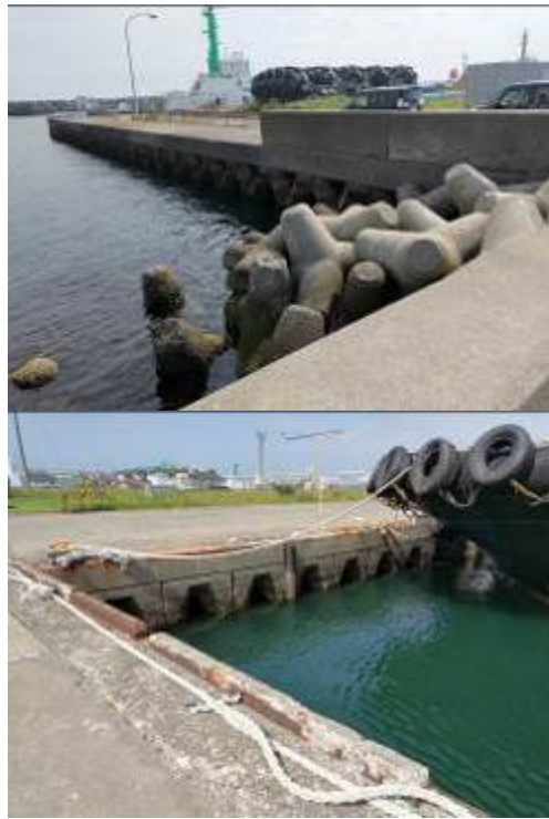
圖2.24 苦小牧港西港區內苦小牧漁港的開孔消波碼頭與岸壁
