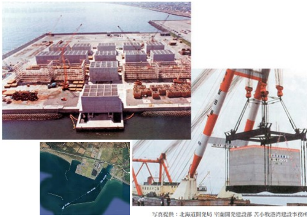
圖2.11 苫小牧港東港區防波堤沉箱預鑄場及吊運下水
