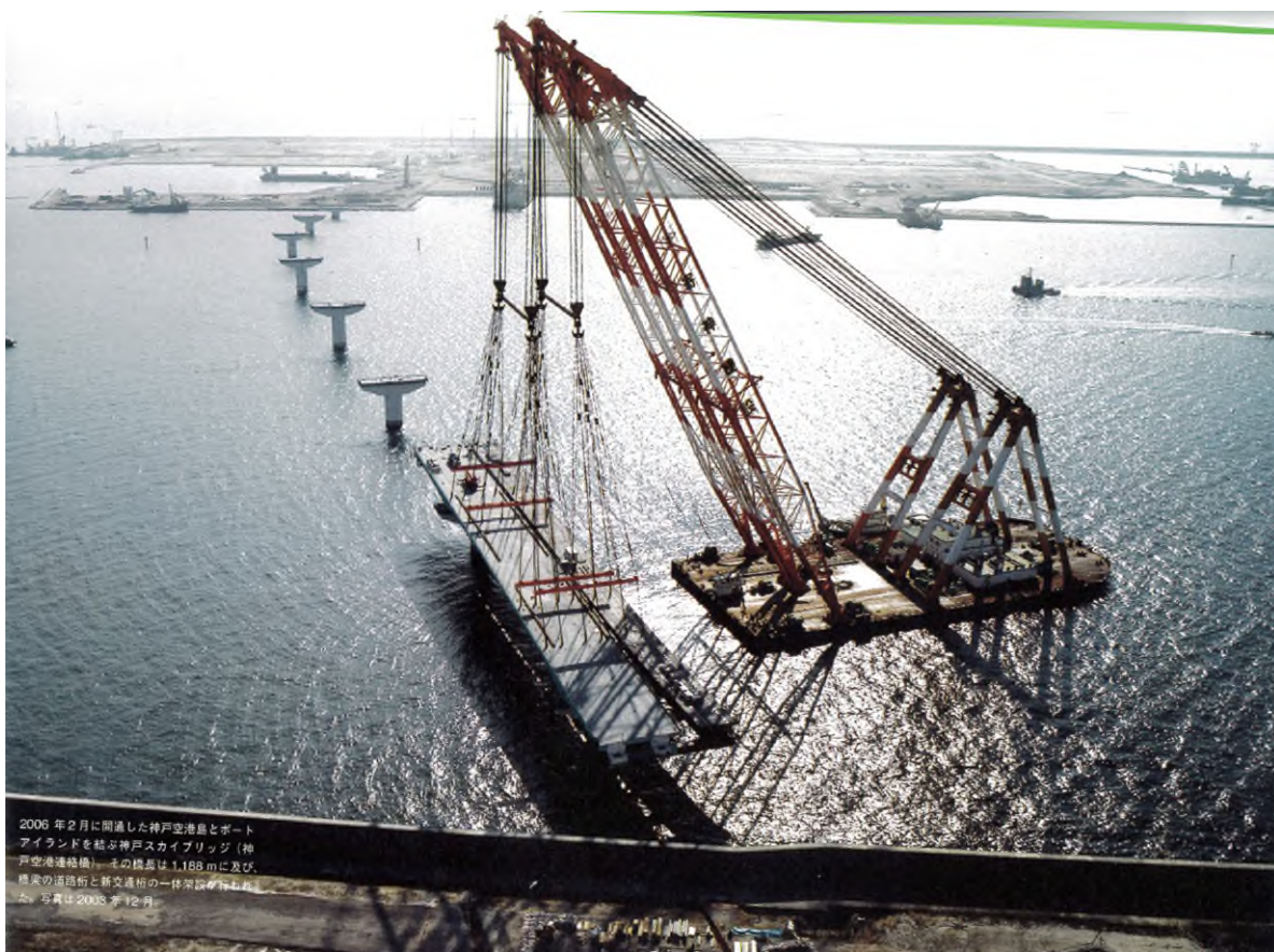
圖 3.2.18 神戸機場人造島聯外橋施工照
