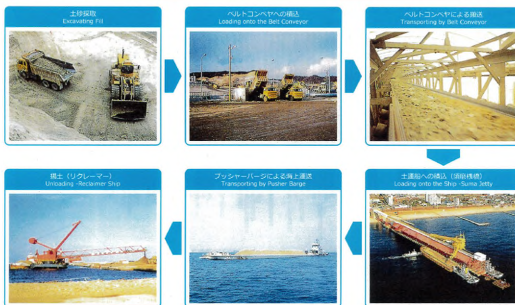
圖 3.2.11 土方搬運(輸送帶)工法-1
