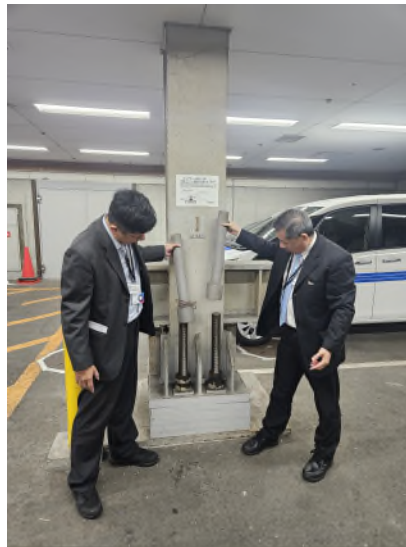
圖 3.1.16 可調式柱底板-1
