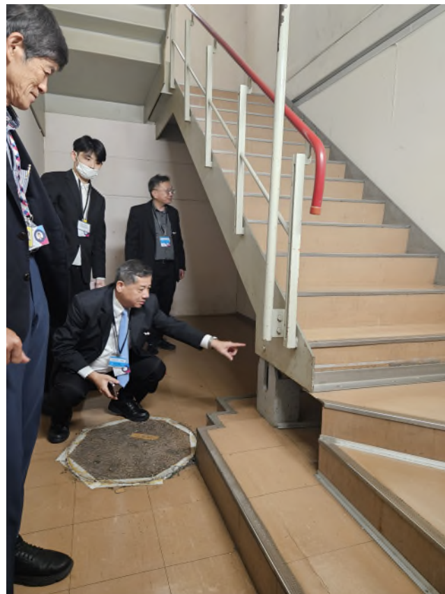
圖 3.1.19 樓梯台階增設
