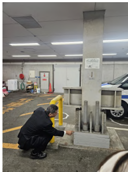
圖 3.1.17 可調式柱底板-2
