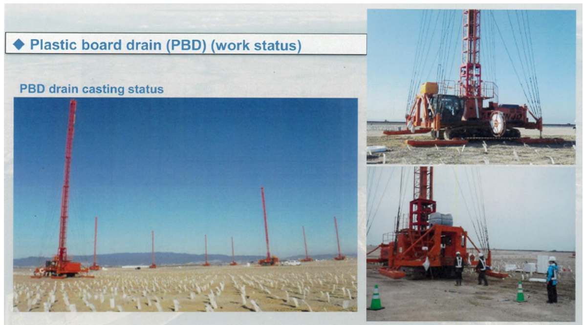
圖 3.3.11 PBD(Plastic board drain) 塑料排水板工法施工照
