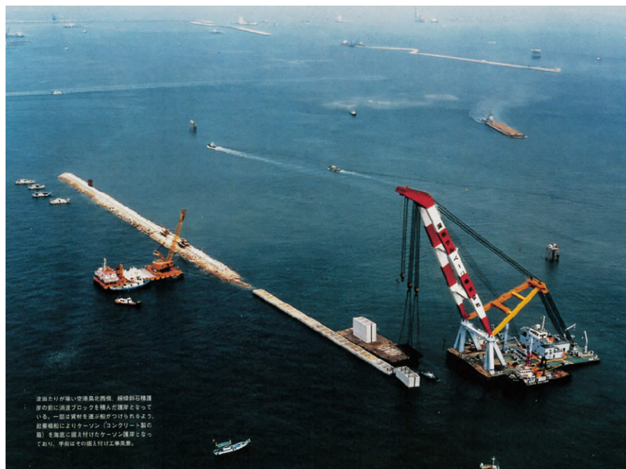
圖3.1.15 海事工程及施工機具-1
