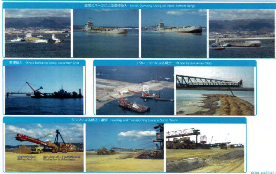
圖 3.2.12 土方搬運(輸送帶)工法-2
