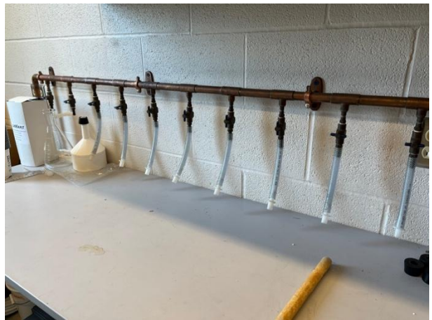
圖 22. 一整排抽氣閥，可接上帶側向通氣口的三角錐瓶，加速萃取土壤溶液。再用萃取水溶液進行成分分析。
