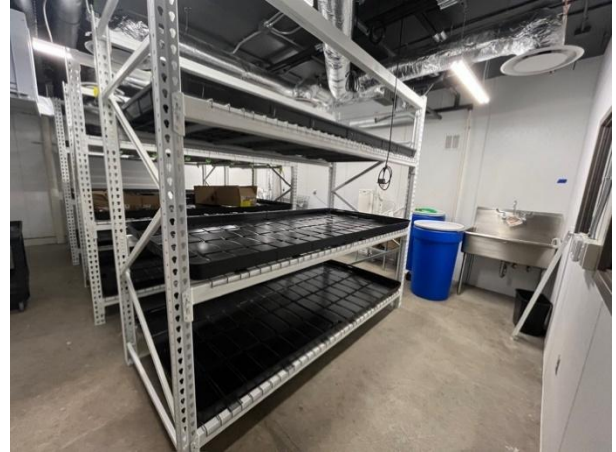
圖 20. 建置中的室內植物工廠，一個層架有三層，採用底部灌溉，可進行不同光照度及光譜的試驗。
