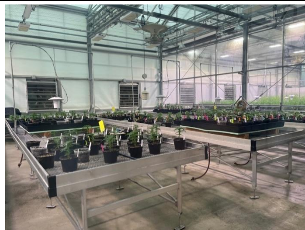
圖 52. 試驗場域分隔成一間一間的獨立空間，內部電照、垂直式風扇、二氧化碳補充等設備均一應俱全。
