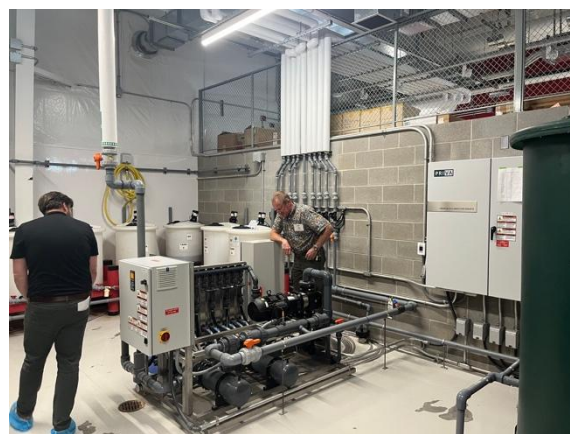
圖 54. 全區溫室的養液調配與輸送系統，多達十條以上管線。
