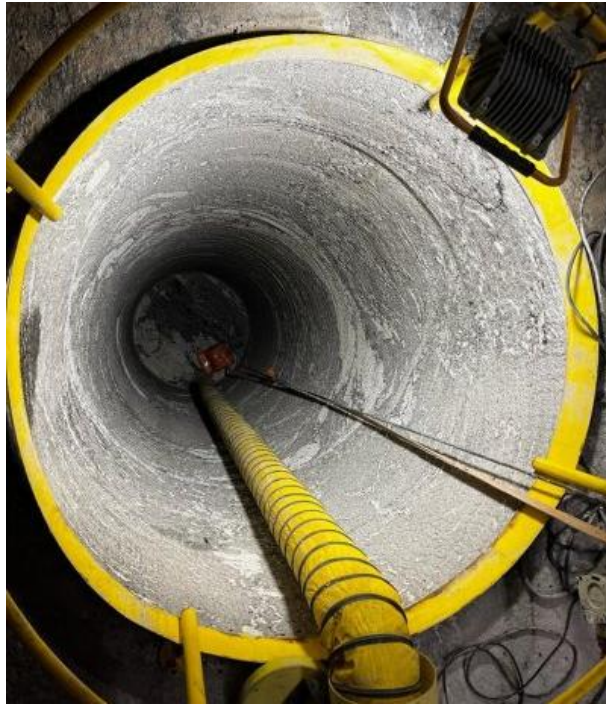
圖 27：Posiva 於 2023 年首次利用 DHBM 鑽孔機完成的處置孔
