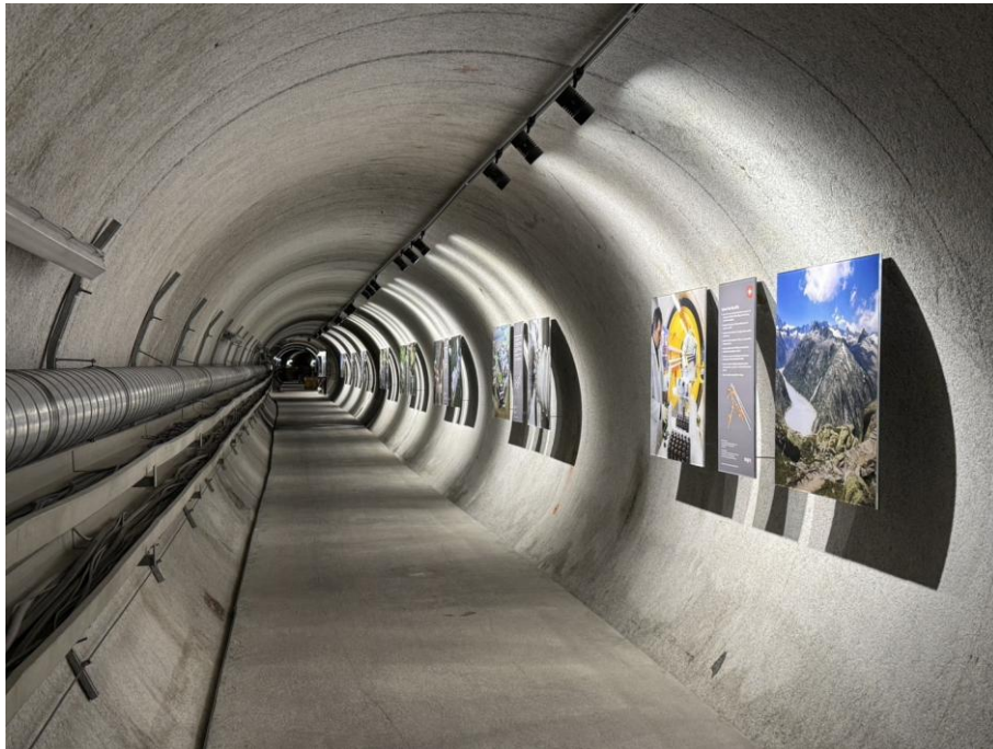
圖 40：GTS 地下實驗室連通隧道
