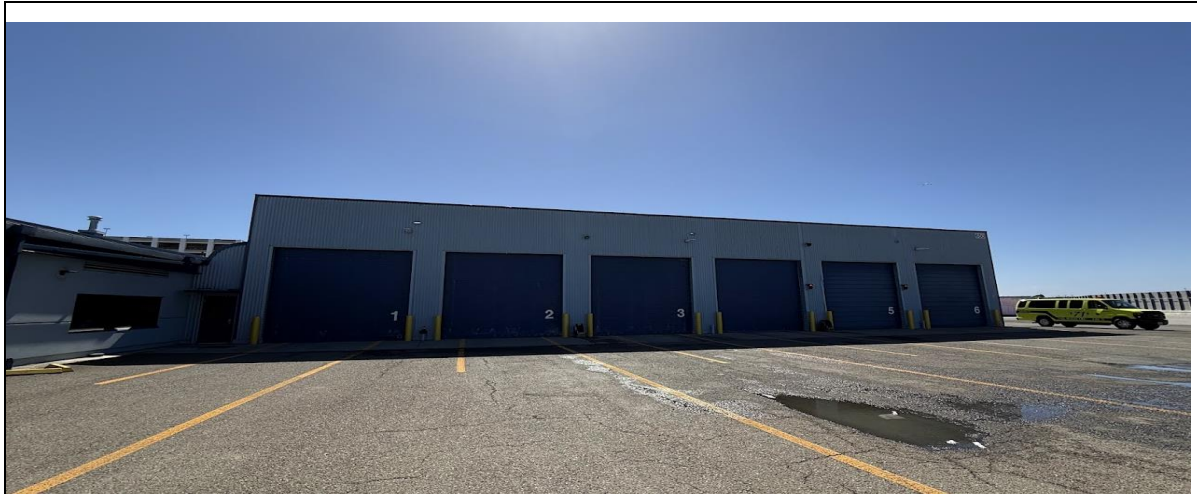
舊金山國際機場 1 號消防站
