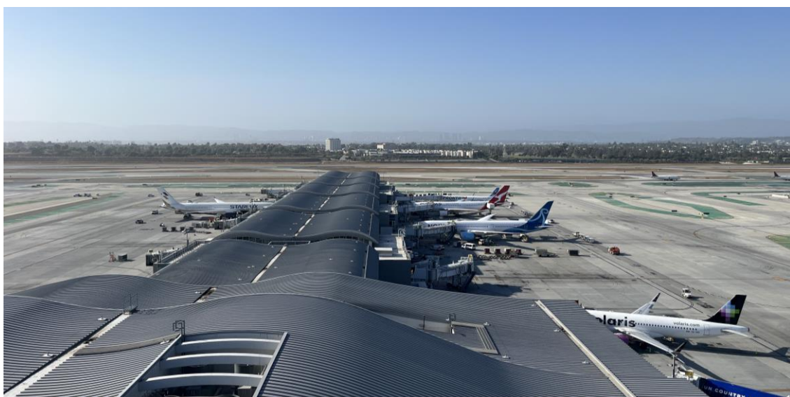
RAMP TOWER 視野
