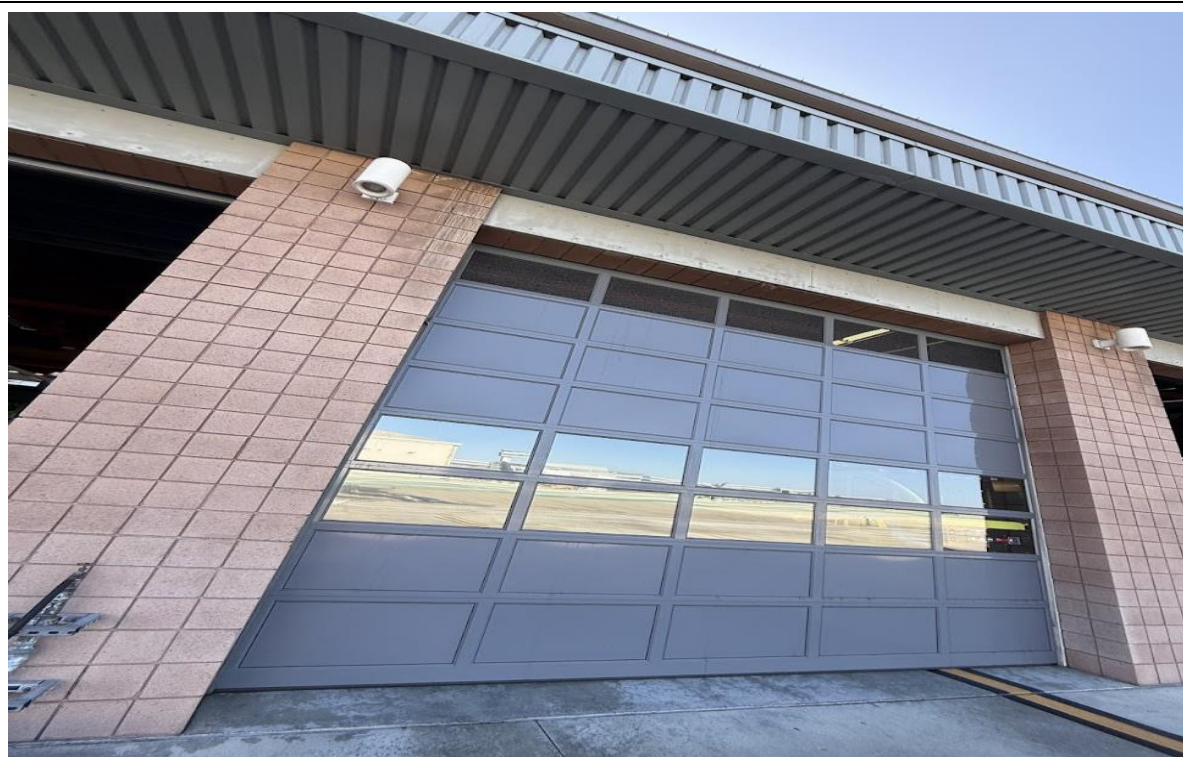
洛杉磯機場 80 號消防站車庫鐵捲門
