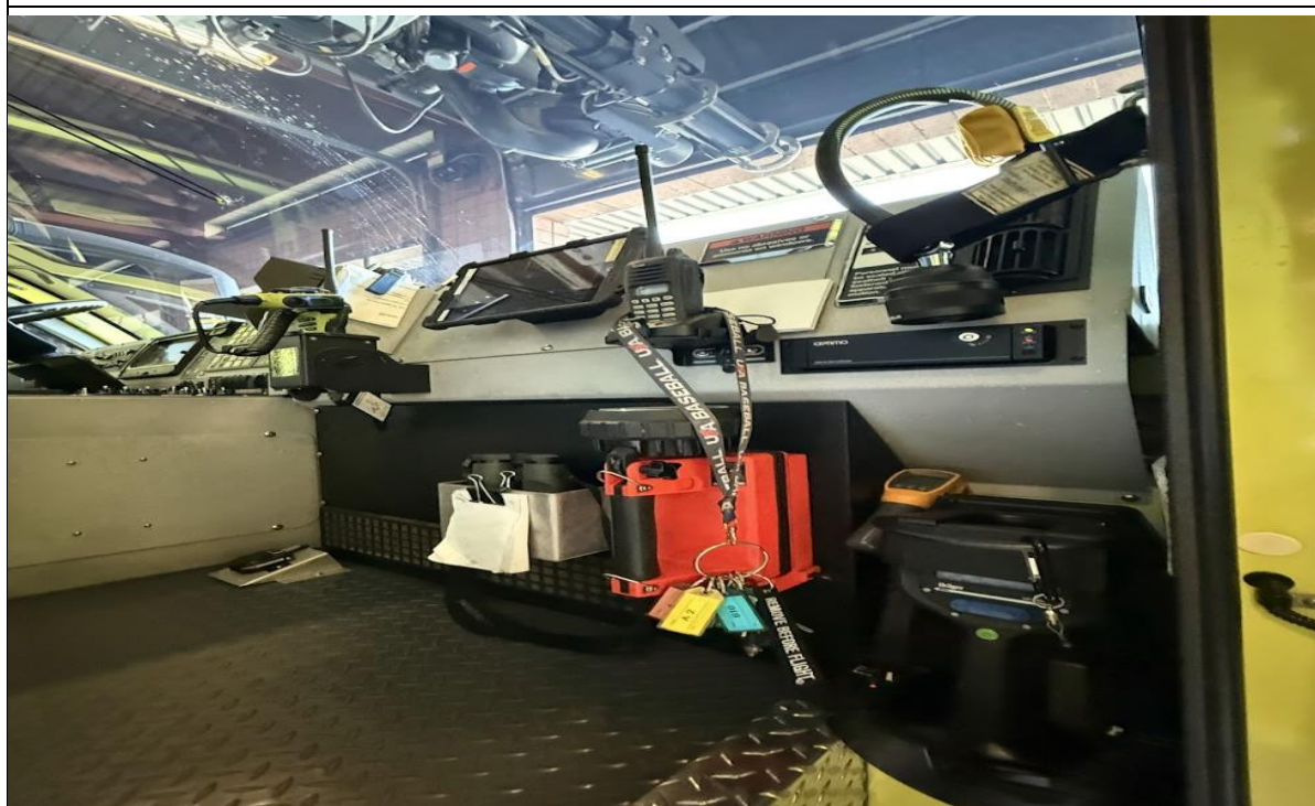
洛杉磯機場消防車輛上精密裝備(熱顯像儀、氣體偵測器、防爆手電筒)
