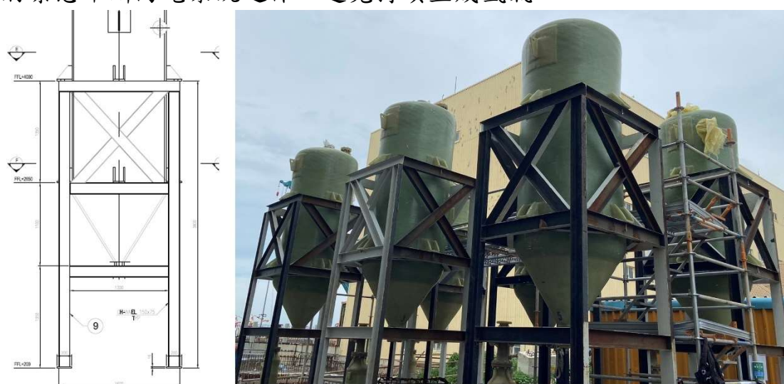
圖 12. 氫氣旋風分離器 GA 圖及實體照
