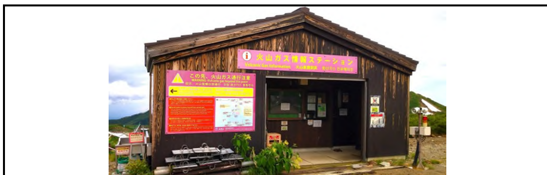
圖 19. 火山瓦斯氣體警報的觀測小屋
