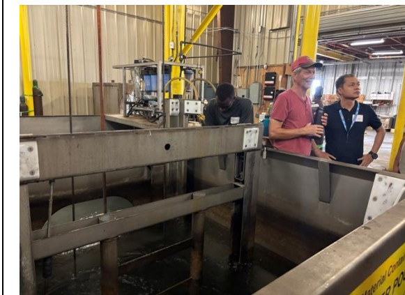
圖二十三、輻射處理設備。
