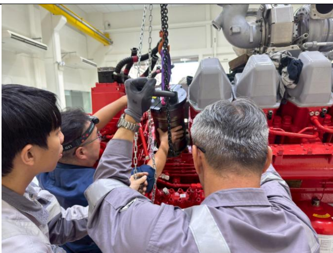
圖 3.2.2-3：缸套、活塞、連桿拆卸與安裝
