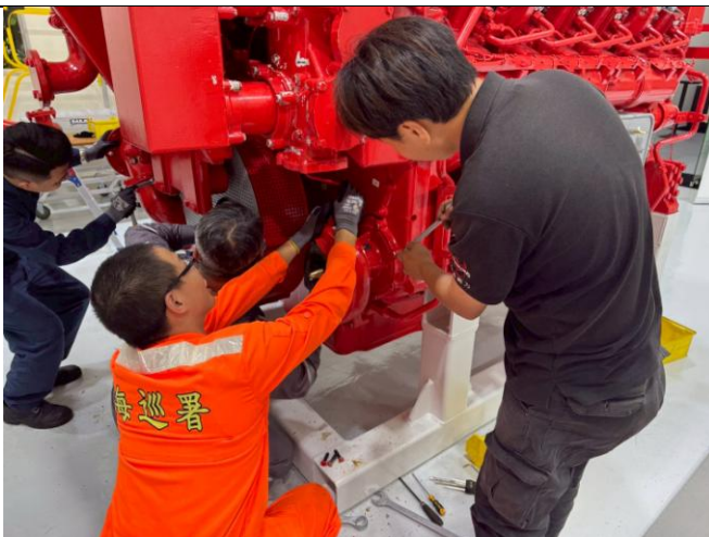
圖 3.1.5-1：高溫淡水泵拆卸與安裝
