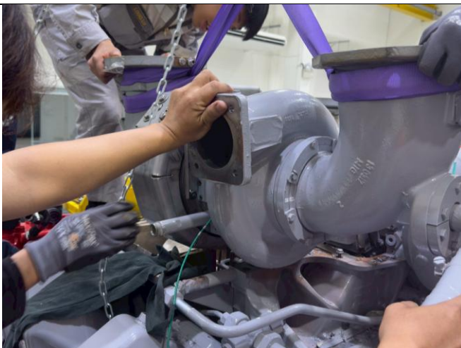
圖 3.2.1-1：渦輪增壓機拆卸與安裝
