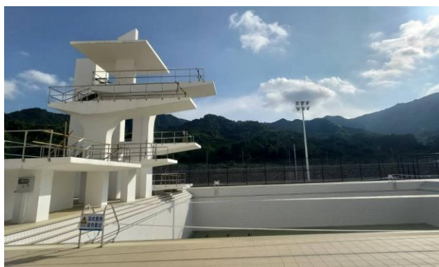
貴安游泳訓練基地－室外跳水池
