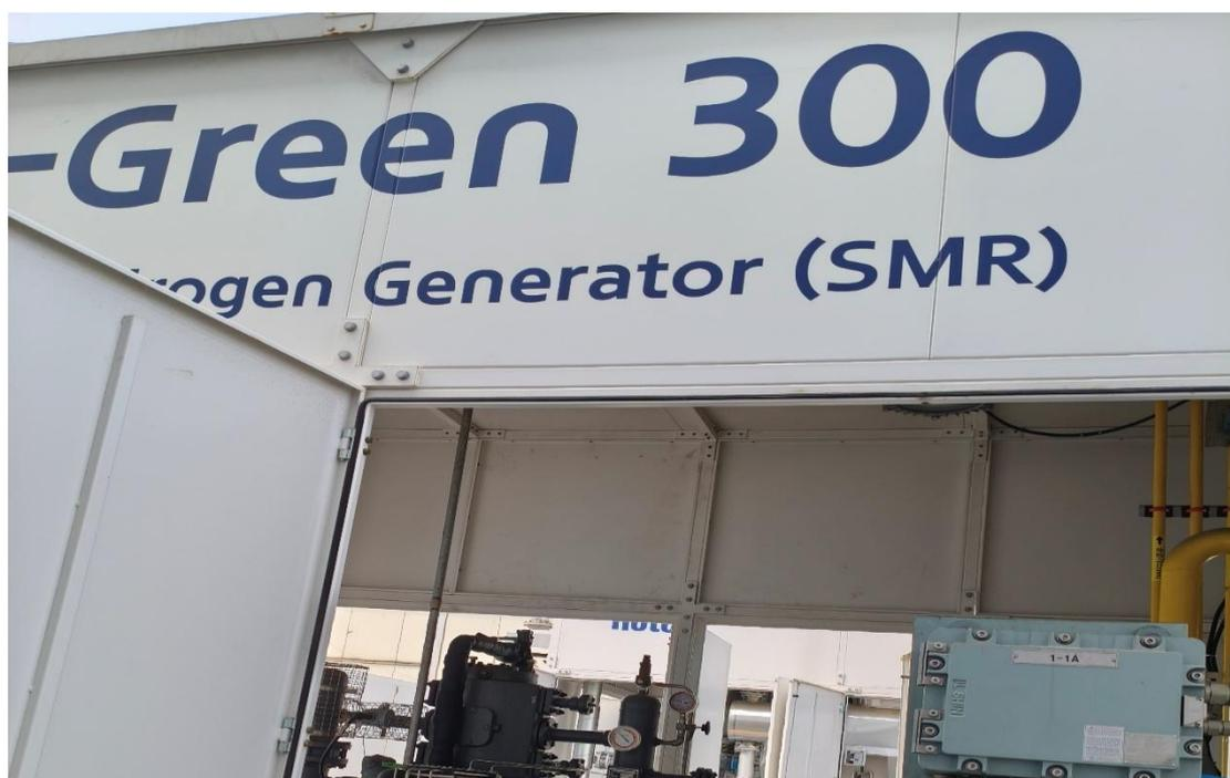
Hy-Green 300 由數個貨櫃連接而成，目視粗估長度約有 20 公尺。產氫流程包含：(1)原料脫硫預處理進行除濕及微粒過濾；(2)甲烷蒸汽重整將碳氫化合物轉化為合成氣；(3)於觸媒反應器中進行水煤氣轉換產氫反應；(4)利用變壓吸附(PSA)技術，從加壓混合氣體透過選擇性吸附，將氫氣以外的  $\text{CO}_2$ 、 $\text{CO}$  及其他雜質吸附，從而得到純度 $\geq 99.995\%$ 的氫氣；(5)將氫氣壓縮儲存在高壓容器緩衝槽，以確保隨時供現場加氫充填使用。當有氫燃料電池巴士來加氫時，專責加氫人員會將 700 bar 加氫槍對準車輛接口連接，加氫槍機械鎖定後會自動密封。加氫機會連接巴士訊號系統進行壓力、洩漏、溫度等檢測，確認無誤後會依 SAE J2601 協議由高壓儲槽供氫，以階梯壓力式進行自動控壓加氫，H70 加氫前會先預冷氫氣至約 $-40^\circ\text{C}$ ，加氫時並即時監測槍體溫度與氫氣流量。
