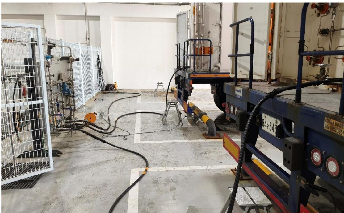
本加氫站氫氣供應來源於兩輛氫氣集束拖車，每輛拖車配置 8 根氫氣管，氫氣由拖車接口連接配氣盤後，依序經過 3 段增壓分裝至 6 根中壓儲氫管集束 (31.15kg, 50MPa)與 3 根高壓儲氫管集束(28.7kg, 87MPa)，確保站內儲氫量充足。當氫燃料電池公車巴士連接 700 bar 加氫槍後，系統在車載氫氣罐壓力與站內儲氫壓力平衡後自動開啟加注，透過加氫機以 700 bar 高壓將氫氣注入車載氫氣罐。氫氣經熱交換器冷卻以抑制加氫過程氫氣罐溫度上升效應。加氫過程由中央監控系統即時監測壓力、流量及溫度，並通過安全閥保護裝置來保障加氫安全與效率。
