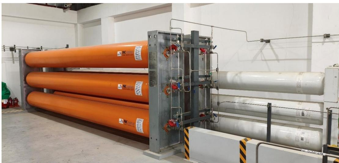
在氫氣儲槽區牆壁貼有加氫站運轉前應確認事項，包含縮機、冷卻器、氫氣系統、系統管路與運轉控制...等設備檢點；另貼有氫氣集束拖車更換作業程序，包含壓縮機停止、車輪止擋器、接地線架設、軟管殘留氣體吹驅(約 0.2 kg)、接頭洩漏檢測...等重點程序。相關維運資料可供未來國內加氫站操作營運參考。
