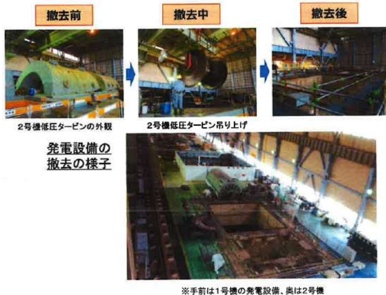
圖 18 美濱核電廠汽機拆除過程 (圖片來源：美濱核電廠資料)
