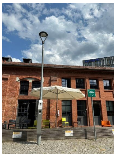
圖19 路燈柱整合式充電樁
