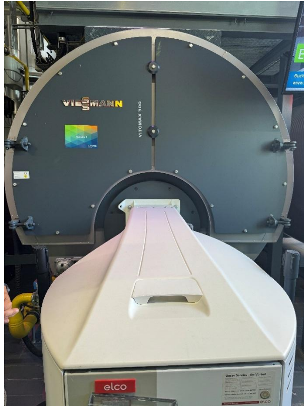
圖17 低溫燃氣鍋爐
