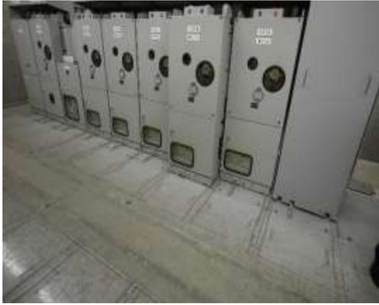
圖 3-27 22kV 斷路器正面
