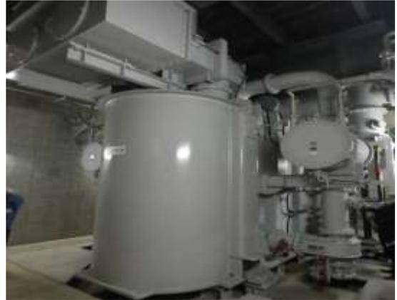
圖 3-23 GIT 主變壓器
