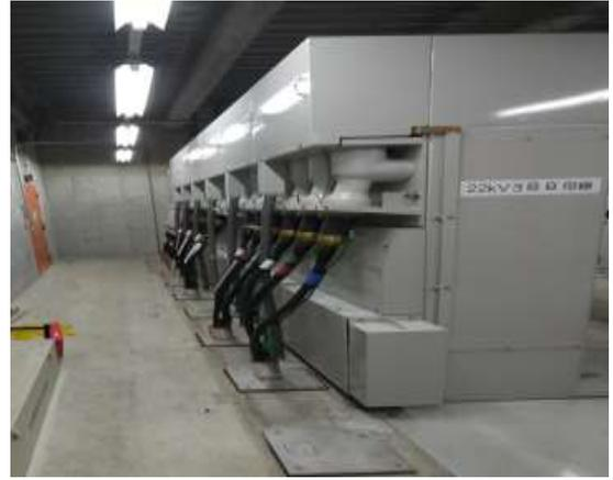
圖 3-28 22kV 斷路器背面
