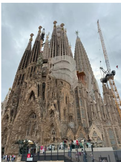
高第建築-施工中的聖家堂
