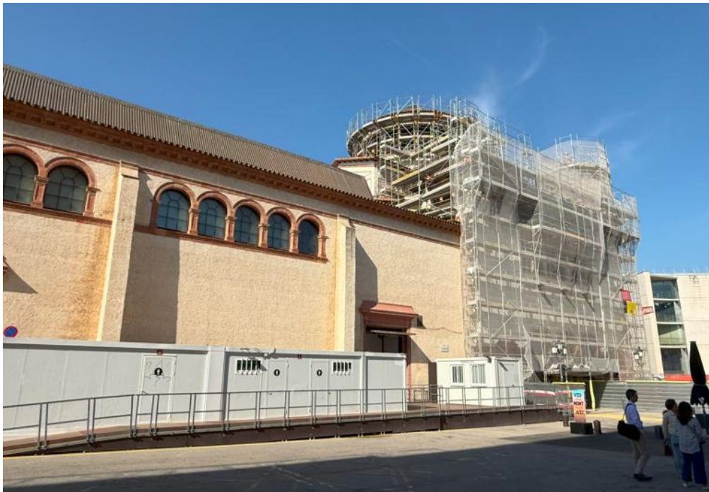
花市劇院現況-整修外觀
