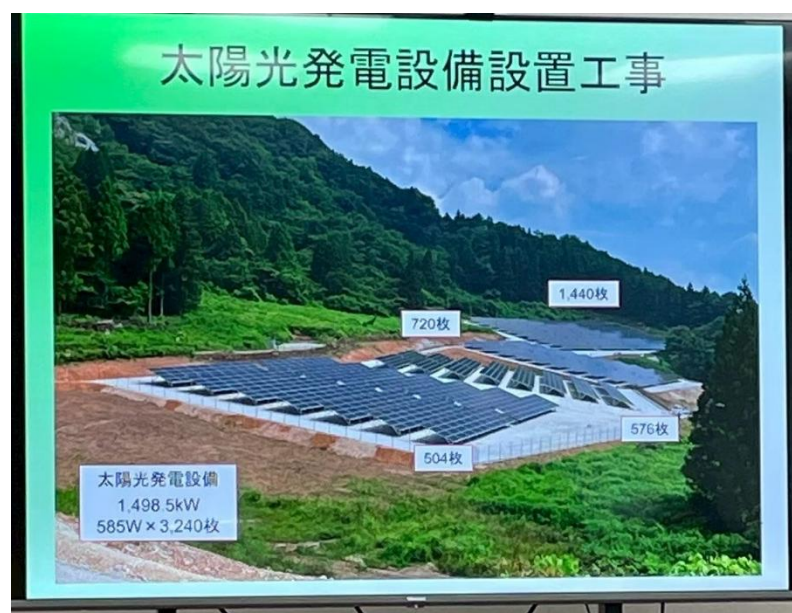
圖4.2.4 鳥形山礦場太陽能板設置工程
