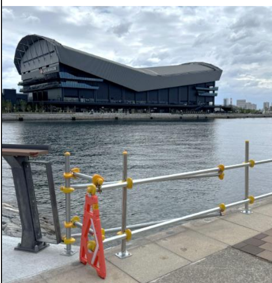
圖 27 臨時施工護欄整潔兼顧安全性
