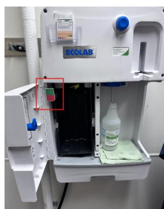
圖十三、消毒溶液稀釋機，利用重量原理，當瓶身越輕，則外觀會呈現紅色標籤，用於提醒人員進行補充。
