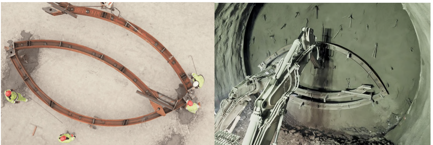
圖 14 Maccaferri 公司研發之鋼支保組立作業
