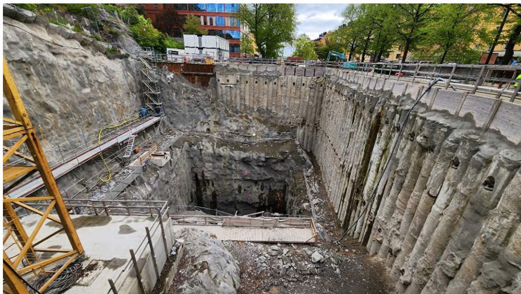
圖 22 索菲亞站電梯井施工照片
