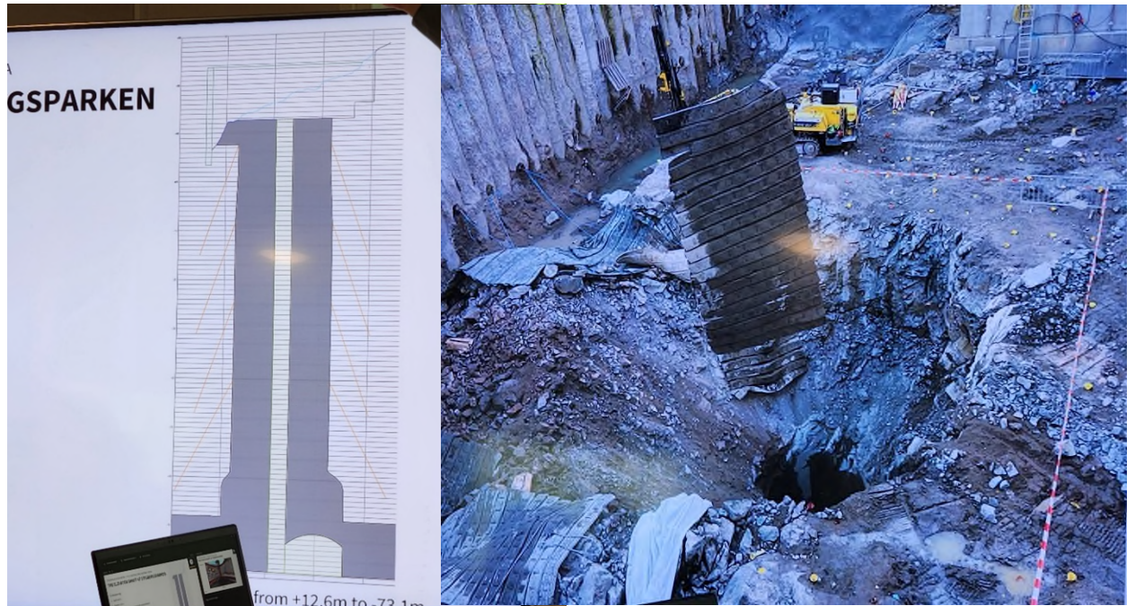
圖 21 昇井工法示意圖及擴孔完成照片
