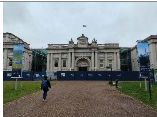
圖 1-2 正門由於正在進行海王星中庭屋頂的玻璃更換而關閉，未來將以海洋中庭的新名稱重新改放
