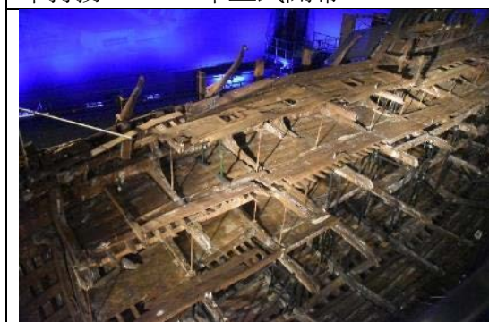
圖 2-21 Mary Rose 現在被存放在博物館的正中央，除了溫濕度的控制之外，也有相關監測儀器，瞭解相關木頭的變形情況
