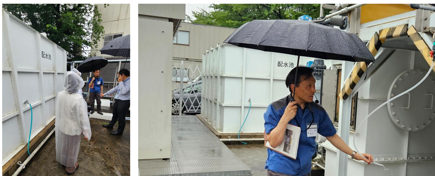
圖 21 左：清水池取水採樣點、右：膠羽池取水採樣點
