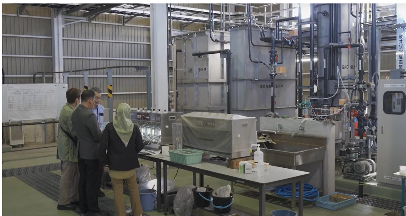
圖49 淨水操作實務訓練現場
