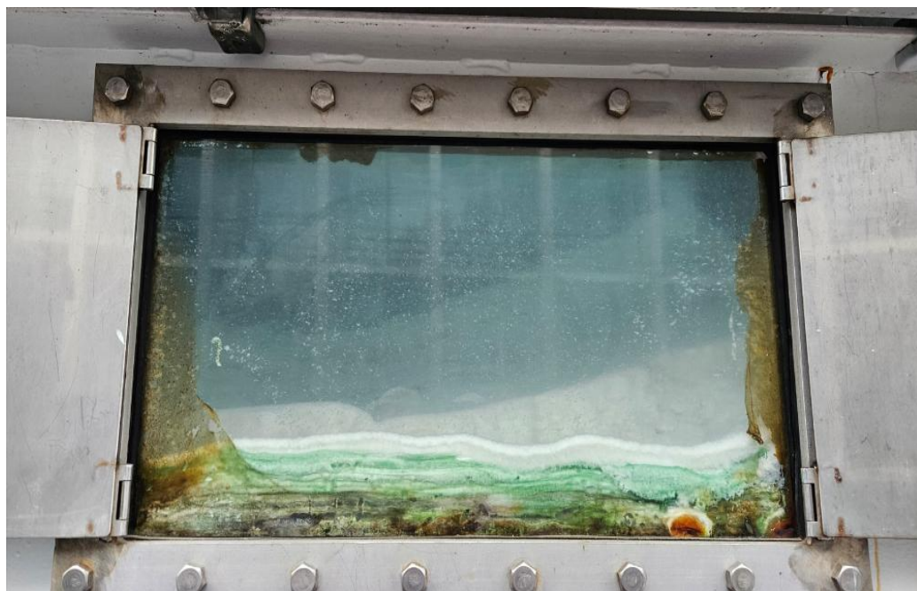
圖 23 左：膠羽池底部的觀察窗、右：膠羽池上方的觀察窗
