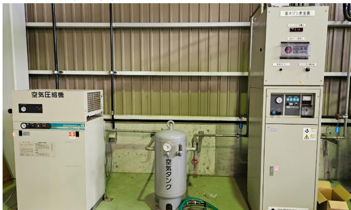
圖 37 空氣壓縮機、空氣鋼瓶與臭氧產生器
